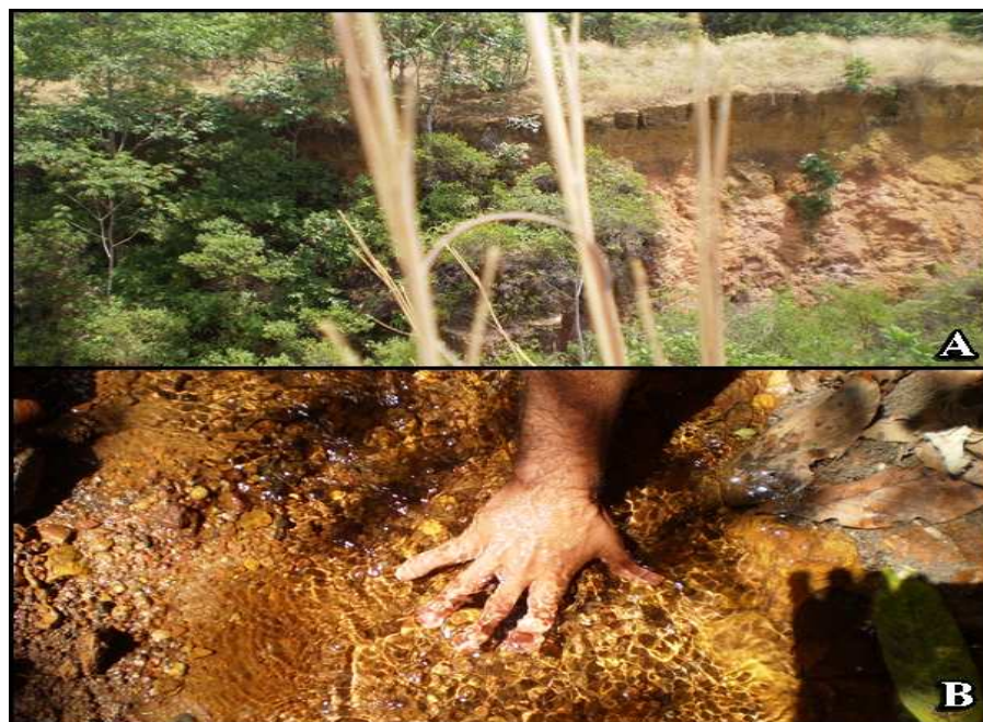
Figura 27. Problemas ambientais observados no córrego Gengibril, Anápolis, GO. (A) Voçorocamento provocado por águas pluviais e desmatamento. (B) Leito do córrego Gengibril próximo à nascente.
