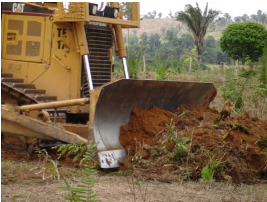
APÊNDICE 17 - Limpeza e enleiramento da área experimental com trator de esteira.
