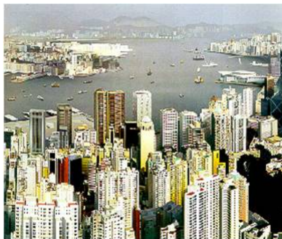
Figura 40: Foto Hong Kong, cidade compacta
