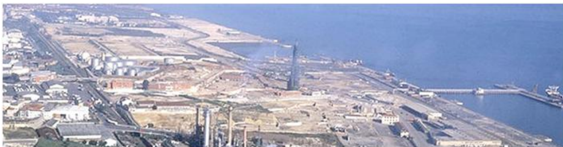
Figura 64: Área antes da intervenção urbana, Lisboa
