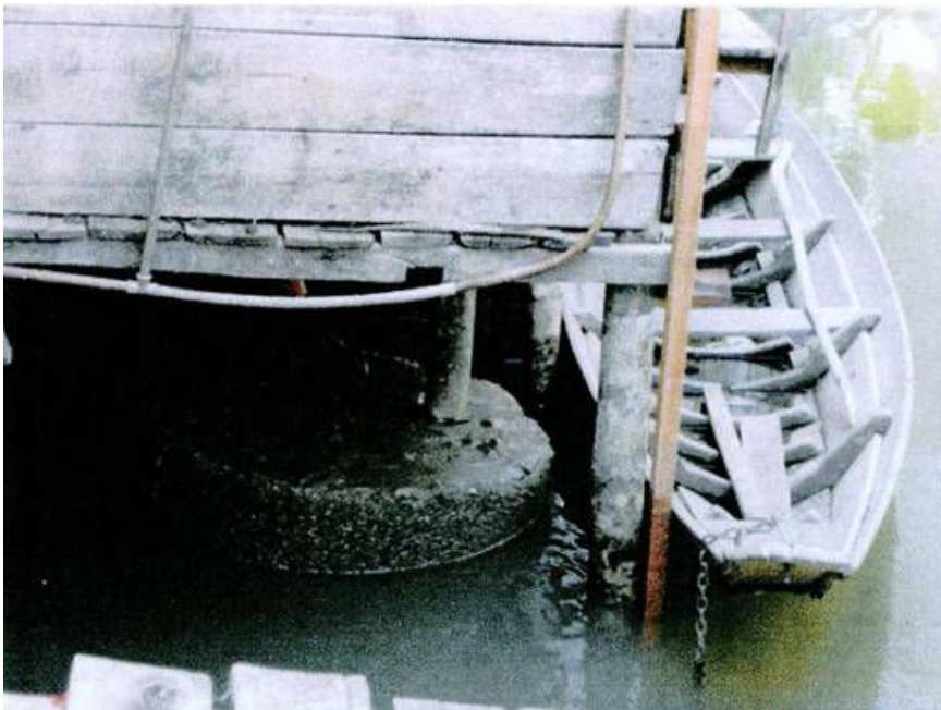
Figura 10 – Fossa séptica submersa no Igarapé da Maria Coroa Fonte: B. E. Silva, 2008
