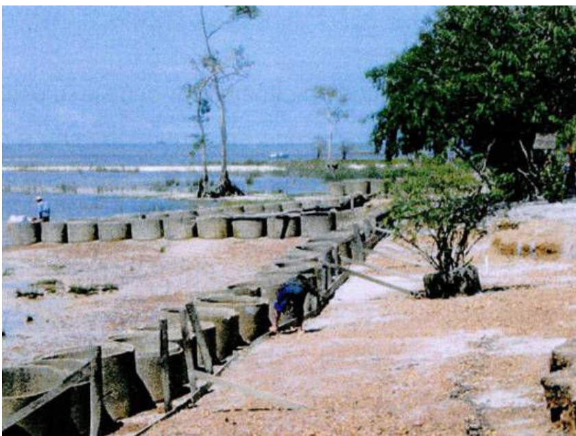
Figura 24 – Manilhas de concreto e sedimentos de aterro ao longo da orla Fonte: M. C. BEVILAQUA, 2008
