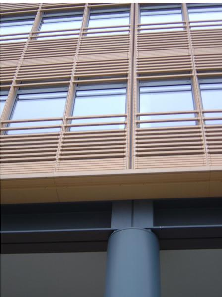
Figura 46. Edifício Debris: detalhe do brise cerâmico na fachada externa
