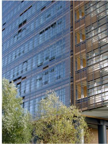
Figura 44. Edifício Debris, em Berlin: vista da fachada dupla ventilada, à esquerda, e da fachada com brises cerâmicos, à direita
