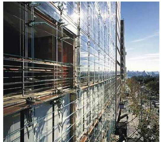
Figura 80. Edifício Aurora Place: detalhe da fachada dupla ventilada com a segunda pele aberta (Fonte: Marcondes, 2004)
