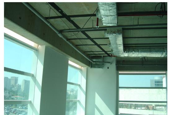
Figura 105. Edifício Eldorado Business Tower: aspecto rosado do vidro branco com a incidência de radiação solar, visto do interior do ambiente, antes do fechamento com drywall
