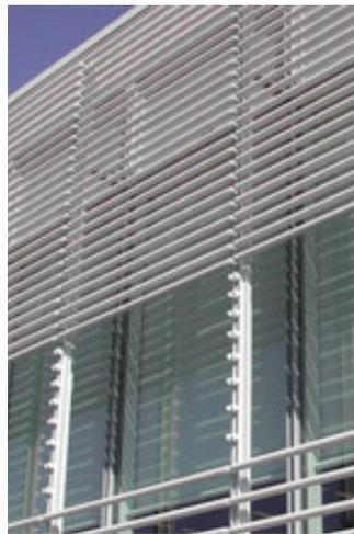
Figura 31. New York Times Building: mock-up de ensaio para avaliação do desempenho luminoso da fachada com brises cerâmicos (Créditos: Vorapat Inkarojrit)
