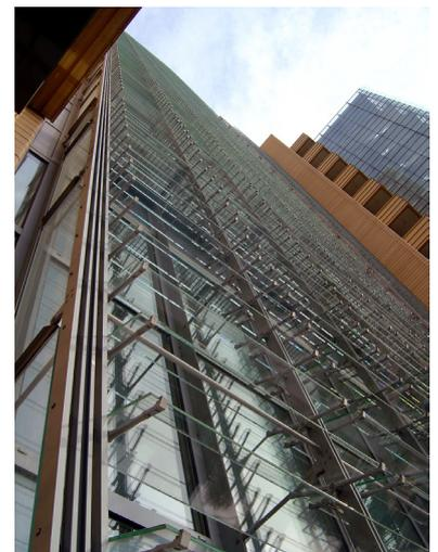
Figura 48. Edifício Debris, em Berlin: detalhe da fachada dupla ventilada
