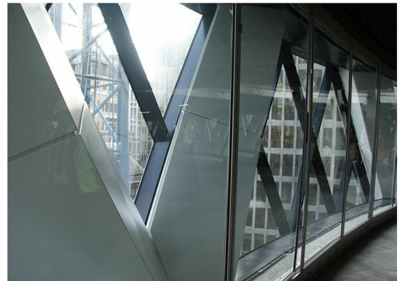
Figura 67. Edifício Swiss Re: vista da fachada dupla ventilada em fase final de construção do edifício
