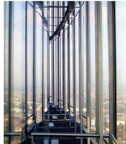
Figura 61. Deutsch Post, em Bonn, Alemanha: cavidade da fachada dupla ventilada, a norte (Fonte: Wells, 2005)
