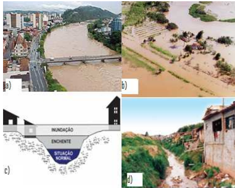
Figura 2. 1 - Situação de enchente em um canal de drenagem (a), Inundação de terrenos marginais (b), Perfil esquemático do processo de enchente e inundação (c), Área de risco de enchente e inundações, associada à ocupação de baixa renda (d).
