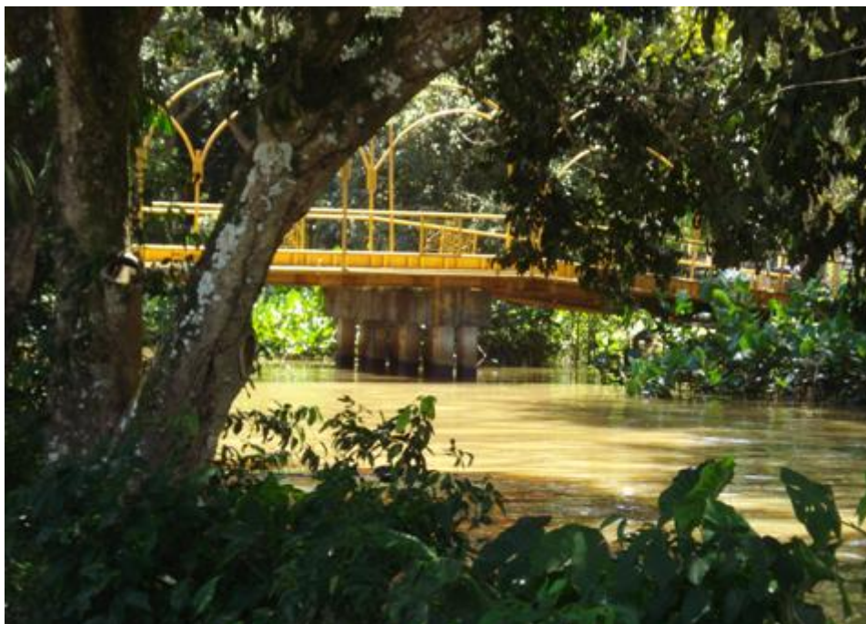
Figura 60. As águas barrentas no igarapé Tucunduba. Ponte para transporte de veículos dentro do campus universitário da UFPA.
