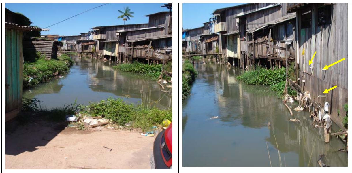
Figura 50a. Palafitas sobre o leito do igarapé. 50b. Despejo de efluentes domésticos lançado diretamente no corpo hídrico, situado nas coordenadas geográficas 01° 27' 9" S e 48° 27' 19" W.
