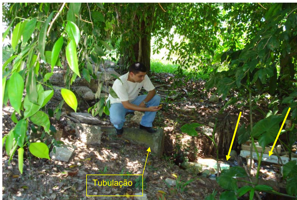
Figura 58. Ponto de lançamento de efluentes, sem tratamento dentro do Campus da UFPA, situado nas coordenadas geográficas 01° 28' 29" S e 48° 27' 16" W.
