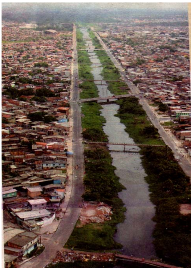
Figura 67. Canal após obras do projeto de macrodrenagem, com asfalto nas marginais. Nas marginais, gramíneas e mato. Fonte: (O LIBERAL, 2010).
