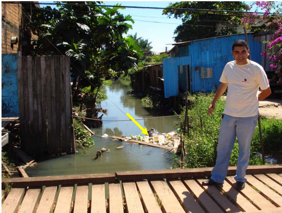
Figura 51. Resíduos obstruindo o curso da água, situado nas coordenadas geográficas 01^{\circ} 26' 58'' S e 48^{\circ} 27' 12'' W.
