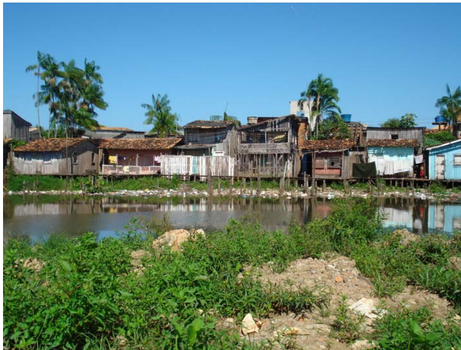
Figura 30. Resíduos sob as casas.
