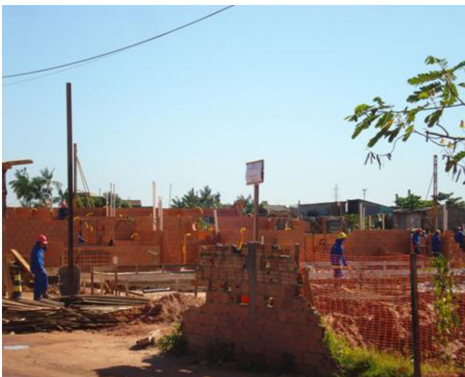
Figura 35. Obras de construção de um conjunto habitacional.
