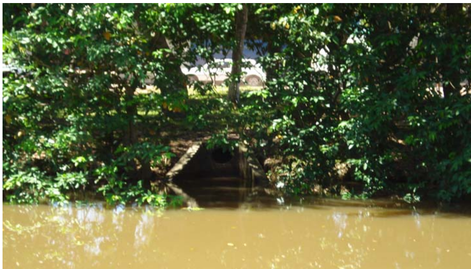
Figura 54. Ponto de lançamento de efluentes, no bairro do Guamá, situado nas coordenadas geográficas 01^{\circ} 28' 18'' S e 48^{\circ} 27' 14'' W.
