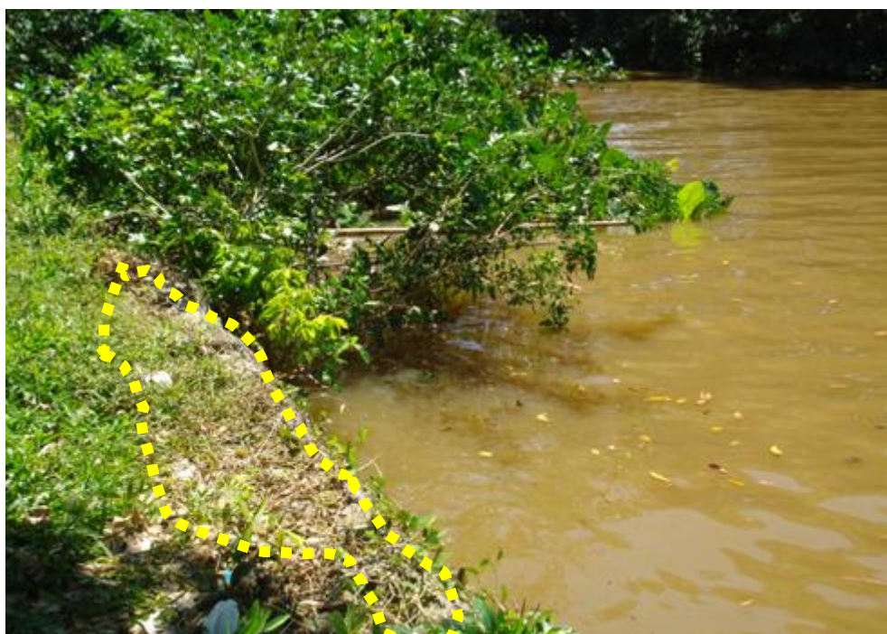
Figura 65. Uso de gabião para conter a erosão.
