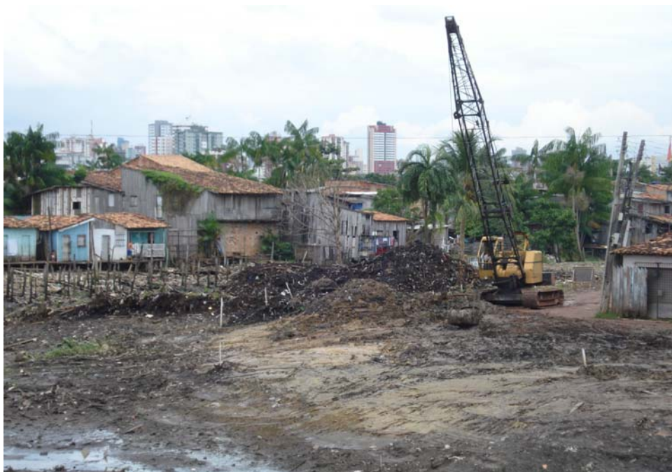
Figura 32. Máquina “Drag Line” em operação de limpeza das áreas de margem já desapropriada, situada nas coordenadas geográficas 01° 27’ 40” S e 48° 27’ 22” W.
