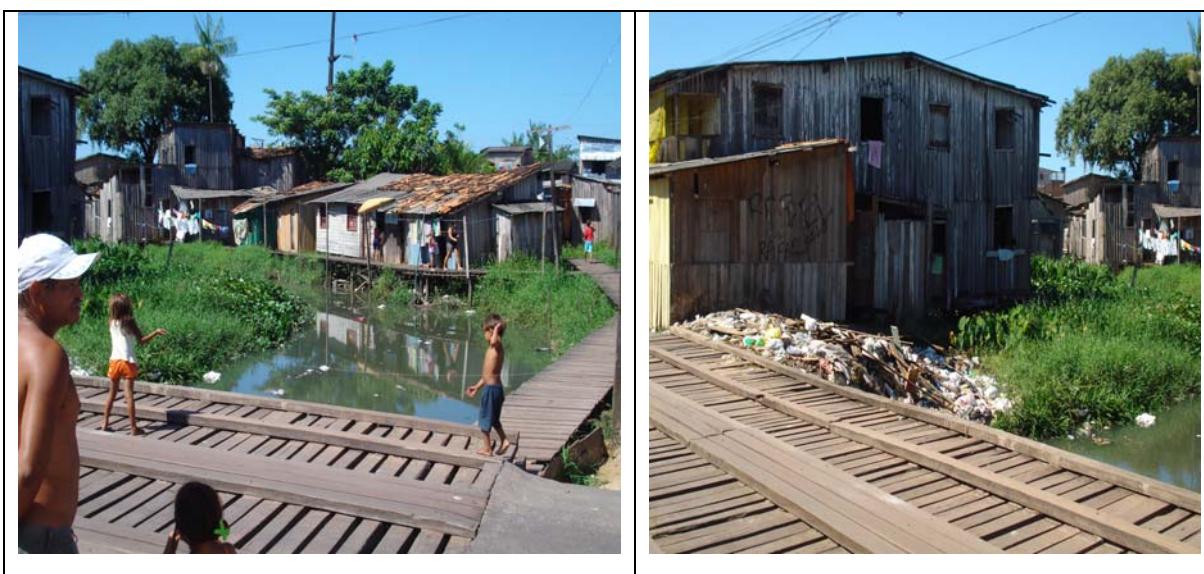
Figura 47a. Ponte na Rua Nossa Senhora das Graças sobre o igarapé do Tucunduba. 47b. Resíduos às margens do igarapé, situada nas coordenadas geográficas 01° 27' 22" S e 48° 27' 15" W.
