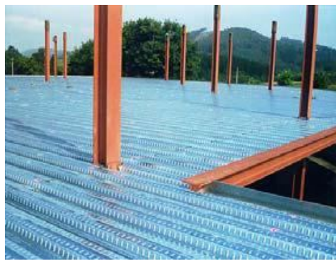
b) Slim Floor desenvolvido na Finlândia
