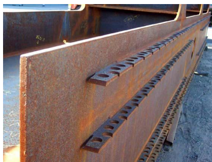
Figura 2.24 – Conector de cisalhamento tipo perfobond (KOTINDA, 2006)
