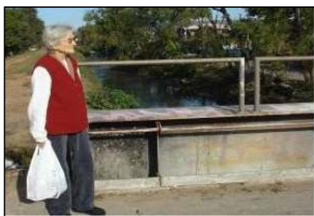
Foto 13 – Vila Minuano: esgoto Fonte: Arquivo da pesquisadora.
