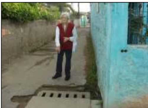
Foto 14 – Vila Minuano: canos de esgoto Fonte: Arquivo da pesquisadora.
