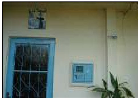
Foto 17 – Fachada da casa de D. Dilecta Fonte: Arquivo da pesquisadora.
