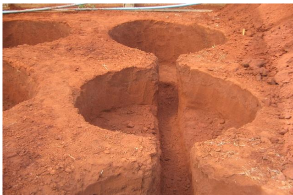
Figura 01 (a) Escavação do solo para implantação dos lisímetros. Fonte: Prior (2008).
