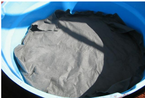
Figura 03 (a) Colocação da manta de poliéster. Fonte: Prior (2008).
