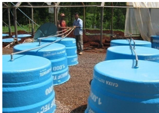
Figura 01 (b) Colocação da tubulação. Fonte: Prior (2008).
