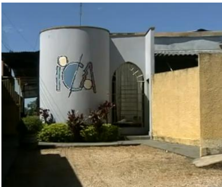
Figura 5 - Foto da sede do ICA (autor)
