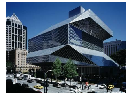
3.7 – 4D – Obra executada
