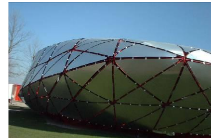
3.2 – 10F – Obra finalizada, painéis fotossensíveis aplicados
