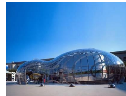
3.5 – 1C – Bernard Franken. Bubble Pavilion, Frankfurt (1999) Vista da obra construída
