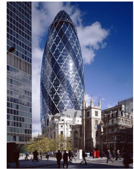
3.7 – 3B – O edifício construído
