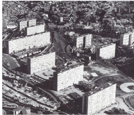
49. Conjunto Residencial 23 de Janeiro (Villanueva, Pintó, p.46)
