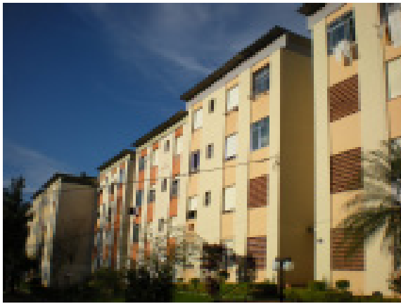
Pequenos blocos alinhados escalonadamente
