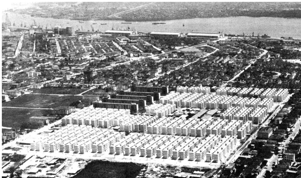
59. Conjunto Habitacional da Ponta da Praia, Santos, SP (Projeto e Construção, n. 7, jun.1971, p. 42)
