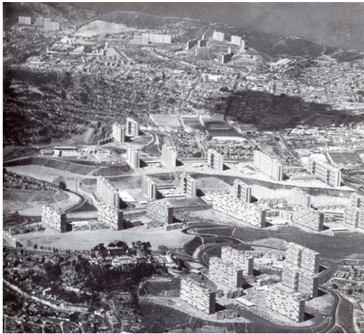
48. Conjunto Residencial 23 de Janeiro (Villanueva, Pintó, p.45)
