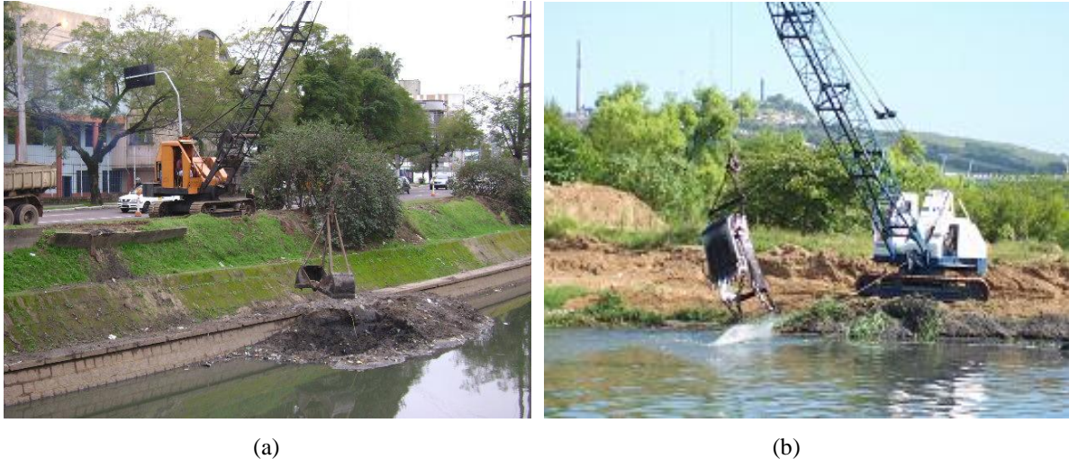
Figura 2.1: Dragas a serviço do DEP, (a) dragas tipo caçamba de mandíbula, na av. Ipiranga e, (b) dragas tipo dragline, na foz do arroio Dilúvio.
