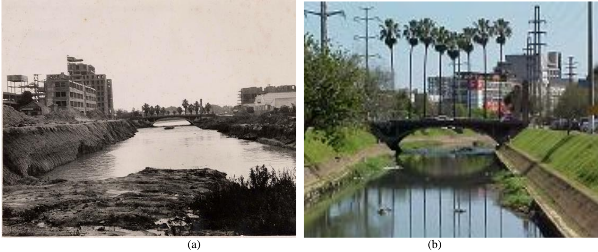
Figura 3.4: (a) Ponte da Av. João Pessoa durante obras de retificação (acervo Fototeca Sioma Breitman, Museu Joaquim José Felizardo) e (b) Ponte da Av. João Pessoa, após as obras de retificação.
