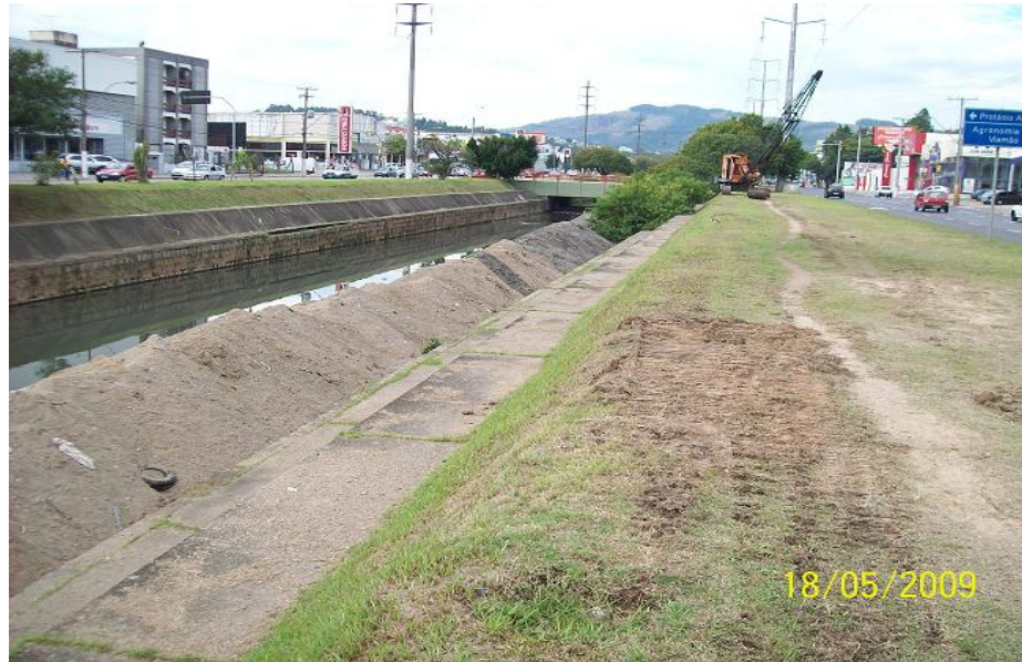
Figura 3.9: Sedimento acumulado na borda do arroio para secagem e posterior transporte
