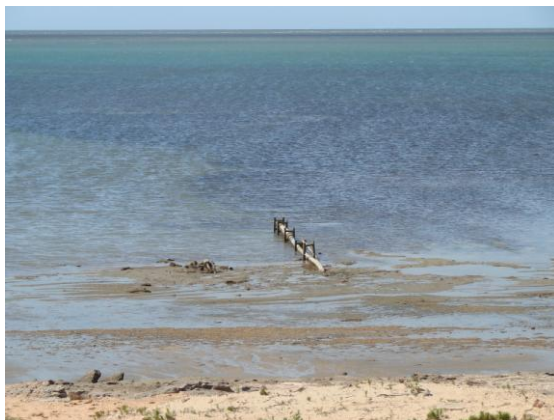
Foto 47. Canalização de água do mar – praia de Barra Grande – Cajueiro da Praia (Foto de Vicente da Silva, julho de 2008).
