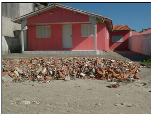
Foto 12. Aterro e restos de construções sobre as dunas frontais, demonstrando o impacto que o Depósito tecnogênico pode causar sobre o ambiente praial (Foto: Ana Fatima da Silva, maio de 2009).
