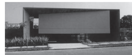
Figura 138: Vista da rua Antônio Unqueira/Fonte: Spiro, Annette. Paulo Mendes da Rocha : works and projects. Zürich: Verlag Niggli AG. Sulgen, 2002. 271 p. : il. p.86.
