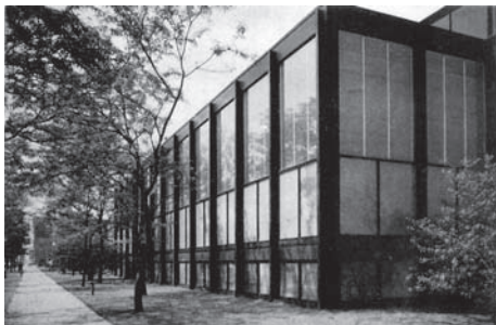
Figura 51-Crown Hall, vista fachada sul Fonte: DAZA, Ricardo. Buscando a Mies. Barcelona: Actar, 2000. 188 p. : il., plantas, fots ,p.63
