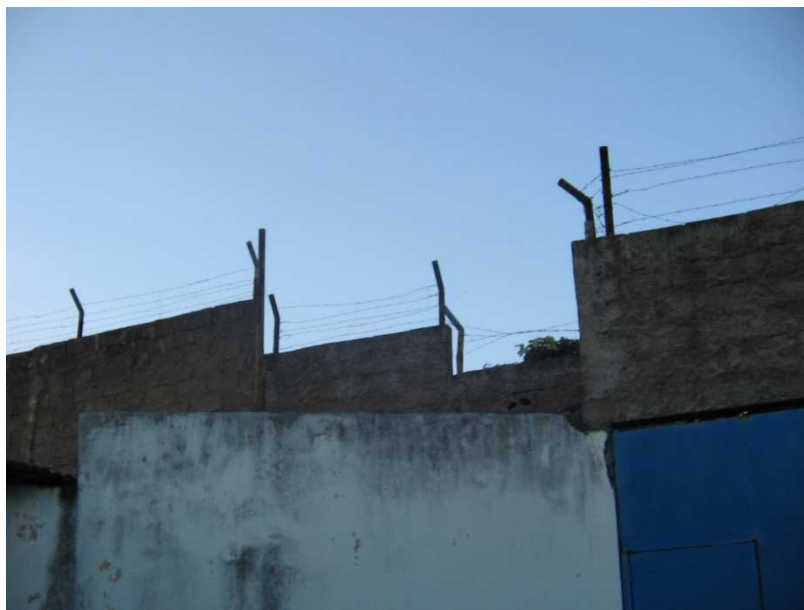
Fotografia 5 – Muros do lado interno Autoria: Vale (2007)
