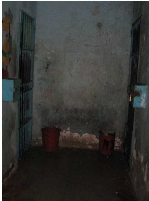
Fotografia 13 – Corredor de alojamentos Autoria: Vale (2007)
