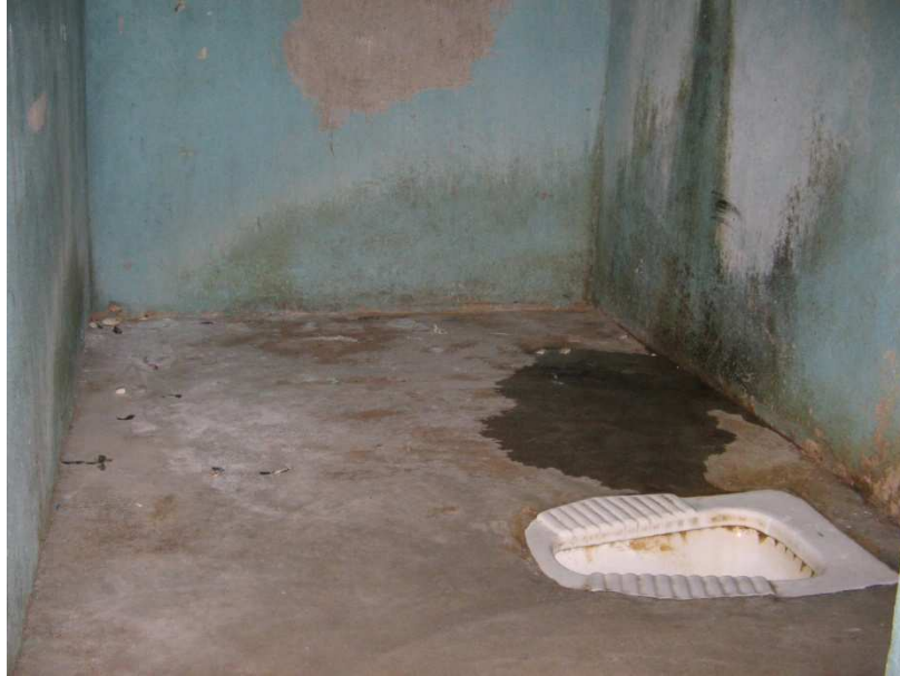
Fotografia 20 – Sanitário I Autoria: Vale (2007)
