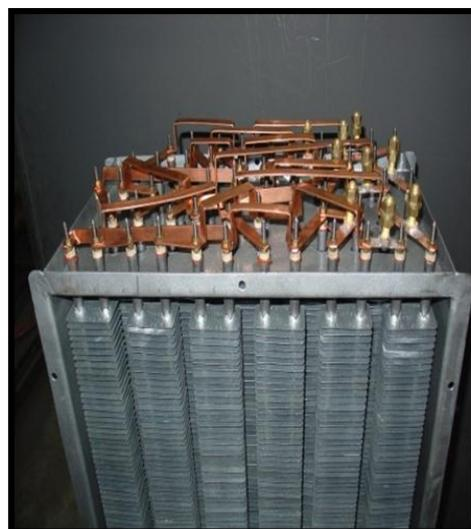
Figura. 22 - Banco de resistência elétrica.
