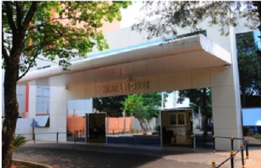
Figura 3 Fachada atual do Hospital do Câncer em Uberlândia
