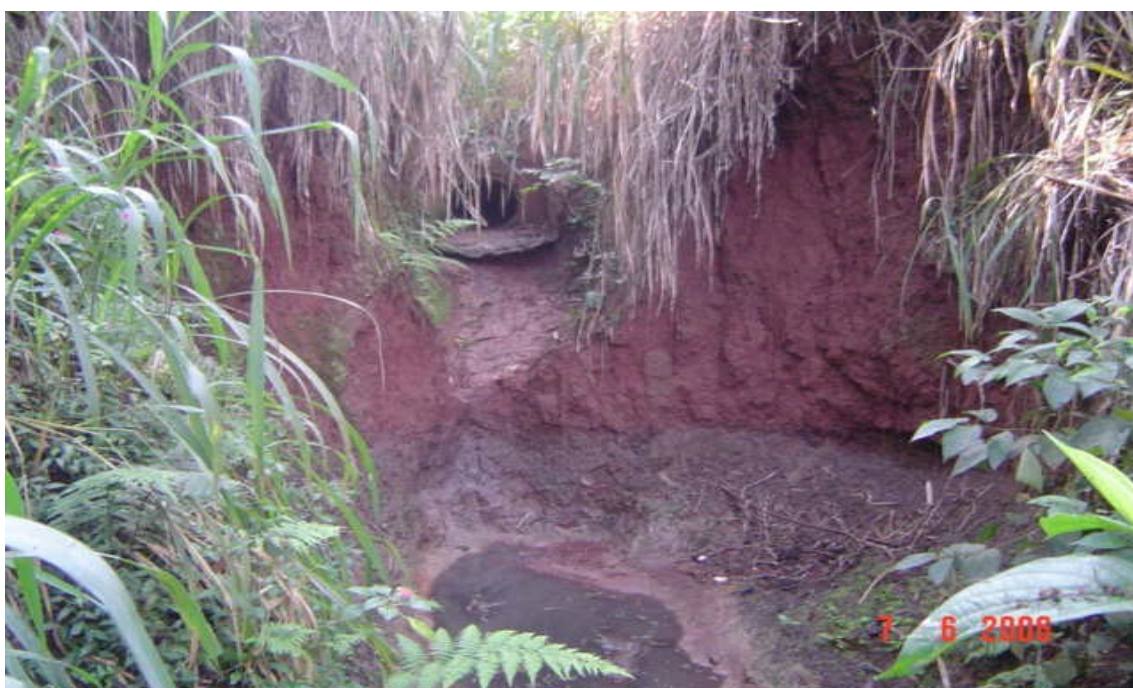
Foto 50 – galeria sem dissipador no córrego Osório, zona norte de Maringá. Erosão de aproximadamente 20 metros. Fonte: SEMA/2008.
