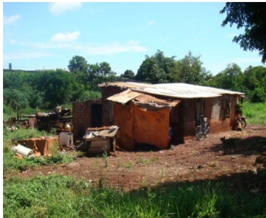
Foto 22 – ocupação em fundo de vale córrego Isalto – Jardim Alvorada. Fonte: SEMA/2007.
