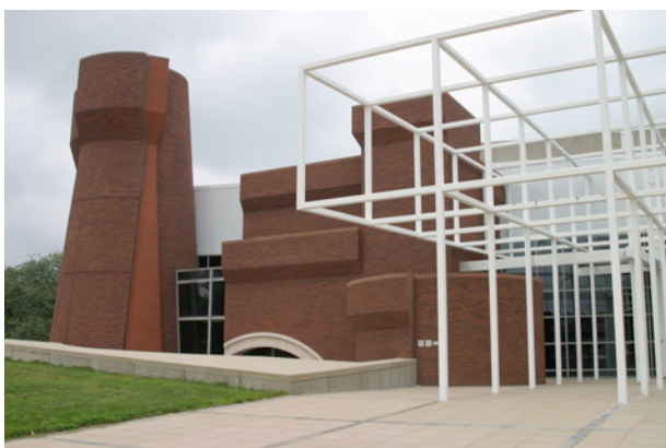
Figura 31| Wexner Center: fachada [fragmento da chaminé e do arco como traços]
