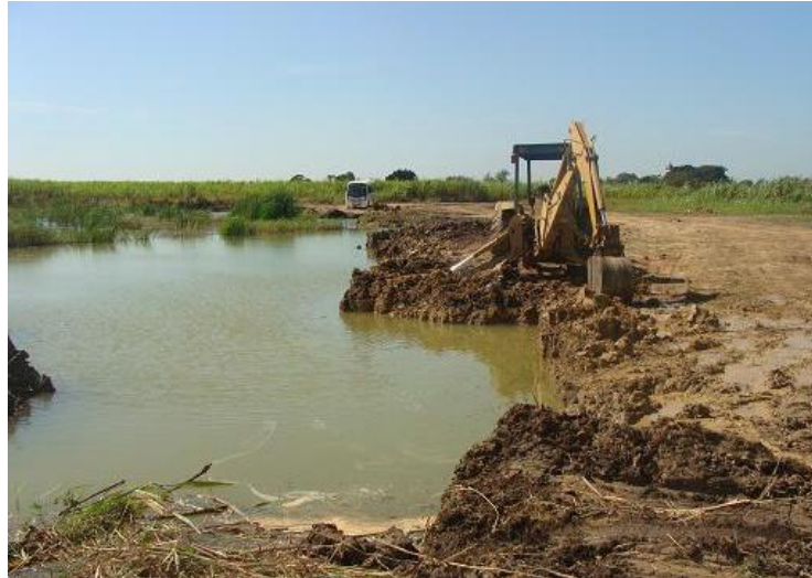
Figura 10 – Preenchimento de água do lençol freático em cava em processo de extração. Foto: do autor.
