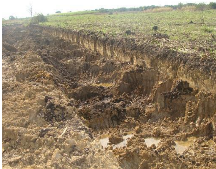
Figura 09 – Jazida após exploração utilizando retroescavadeiras. Foto: do autor.
