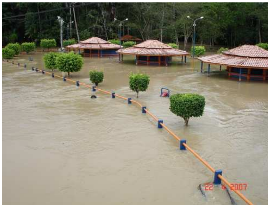
Figura 19 - Enchente ocorrida na vila do Apeú em 22/04/2007 (Fonte: Assad) .
