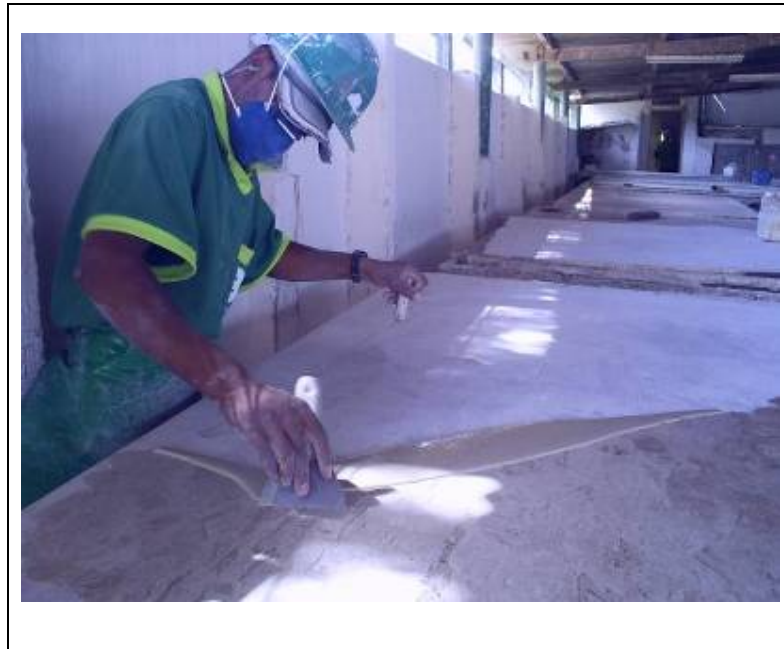
Figura 6: Etapa de resinagem. Foto: Calhau, 2008.
