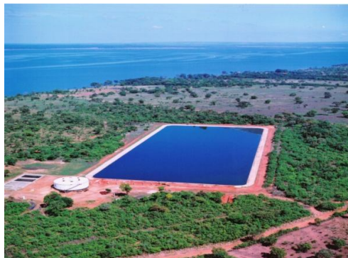
Figura 3 – Lagoa Facultativa da ETE Vila União, Palmas, Tocantins.
