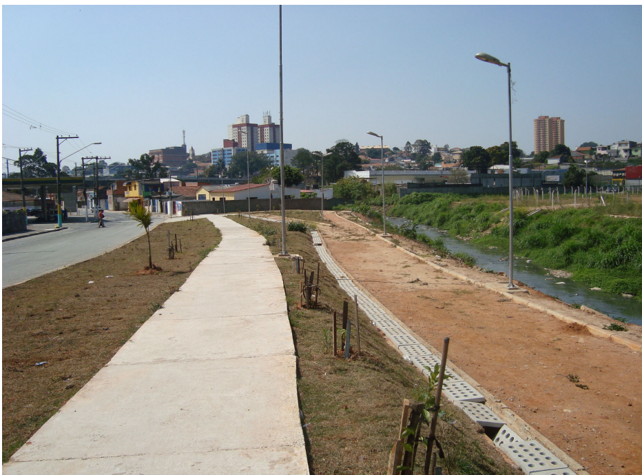
Fotografia 5 – Obras do Parque Linear Rio Verde
