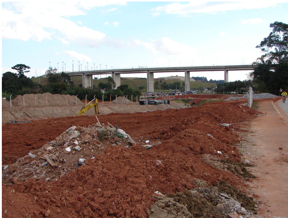
Fotografia 12 – Início das obras. Etapa de preparação de superfícies, à margem direita do córrego, junto à rua Tomazo Ferrara (junho de 2007).
