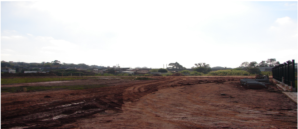
Fotografia 10 – Início das obras do Parque Linear Rio Verde.
