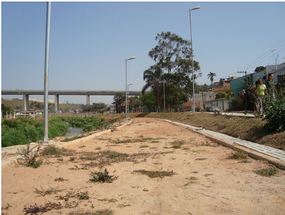
Fotografia 13 – Situação atual à margem esquerda do córrego. Acréscimo de calçamento, iluminação, taludes com gramado, pista de terra batida e grelhas sobre as valas da coleta pluvial.
