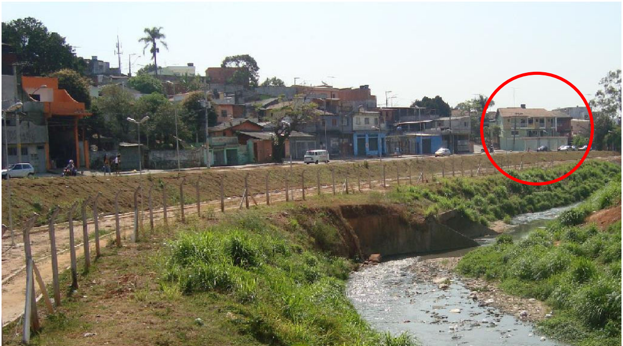
Fotografia 15 - Estágio atual da obra do Parque Linear Rio Verde (agosto de 2010)
