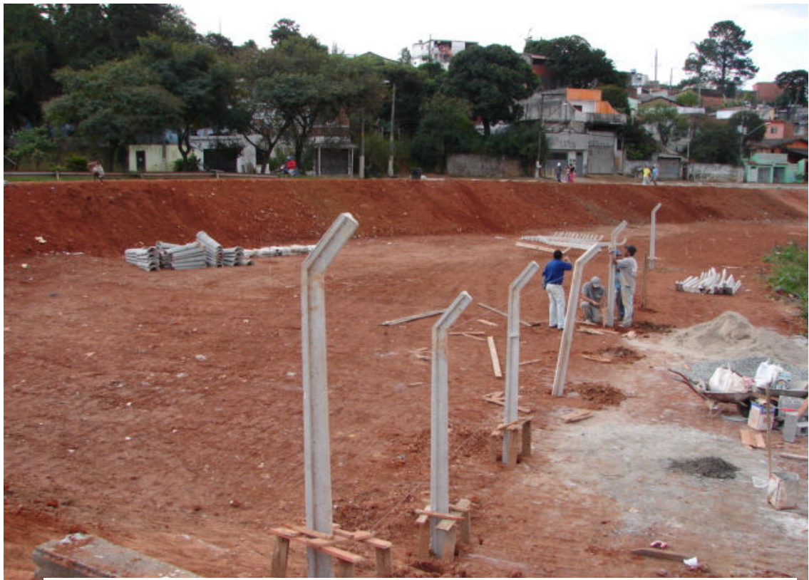
Fotografia 14 – Início das obras do parque do Rio Verde (2007)
