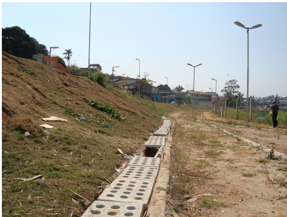
Fotografia 6 – Obras do Parque Linear Rio Verde.
