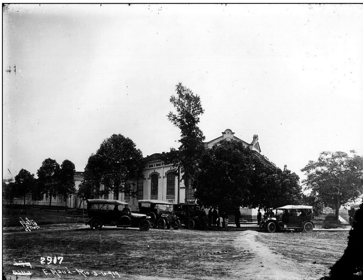
Fotografia 70: Escola Visconde de Mauá. Fonte: Iconografia, AGCRJ. NV0410. Data da fotografia: 03/10/1919. Autor: Augusto Malta. Legenda: “E. Mauá.” Conteúdo: “Vista do prédio Escola Visconde de Mauá, vendo-se automóveis estacionados.”
