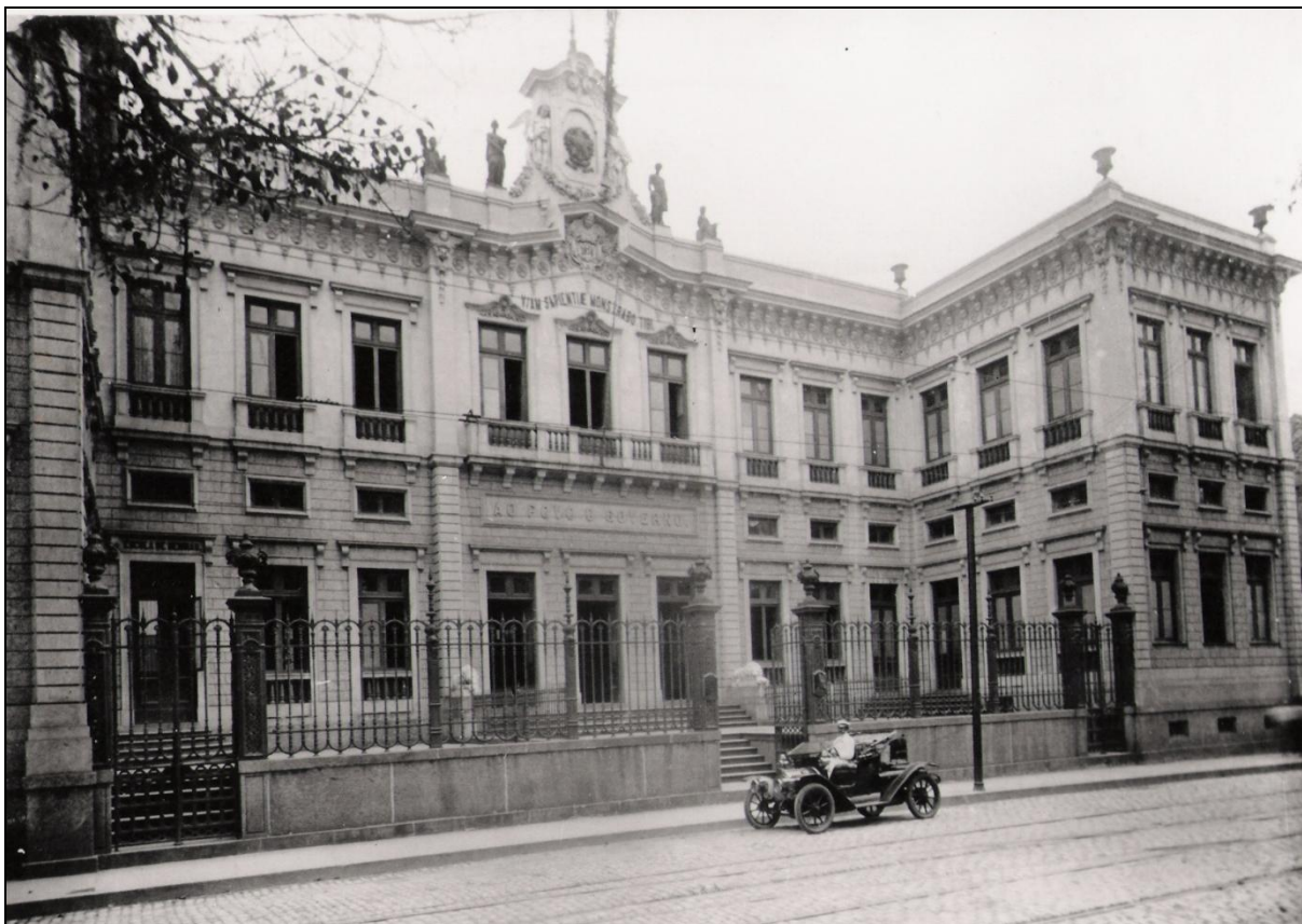
Fotografia 7: Escola da Freguesia de Nossa Senhora da Glória. Na República passou a Escola José de Alencar. Situada na Freguesia de Nossa Senhora da Glória, autor não identificado, sem data. Projeto de Bittencourt da Silva. O primeiro pavimento é revestido em cantaria, e o segundo, “com um entablamento ornamentado, coroadado por um ático com vasos etruscos nos cantos e interrompido no centro da fachada por um frontão, tendo no nicho as Armas Imperiais em relevo, aos lados quatro estátuas representando as Letras, Artes, Comércio e Indústria e, por baixo do entablamento, o dístico: ‘Viam sapientiae monstrabo tibi.’” Também possui a inscrição “Ao Povo o Governo”. No corpo central recuado, no primeiro pavimento, foi prevista a instalação da separação entre os sexos, e as inscrições “escola de meninos” e “escola de meninas”, estão inseridas, cada uma das duas, sobre as portas da extremidade esquerda e direita, respectivamente. Apesar das diferenças desta Escola com a de Santa Rita, projetadas pelo mesmo arquiteto, “os dois prédios se parecem quanto a tipo e distribuição, e quanto ao acabamento dado aos seus vãos e aos respectivos guarda-corpos.” (Sisson: 1990, p. 66) Autor não identificado. Fotografia sem data. Fonte: AGCRJ – Iconografia: pasta 144; registro 565/11. Atual Escola Estadual Amaro Cavalcanti.
