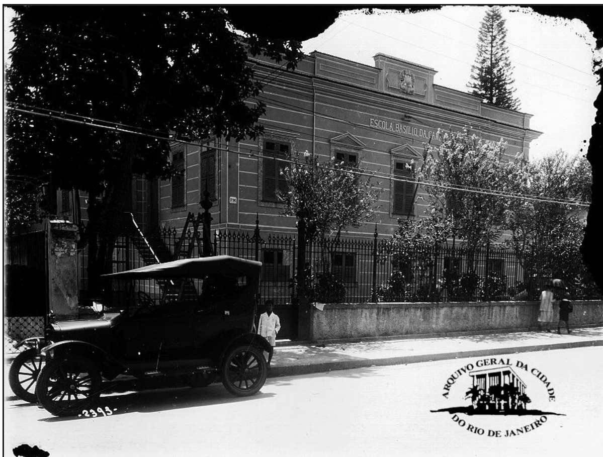
Fotografia 23: Escola Basílio da Gama. Fonte: Iconografia: AGCRJ. NV 0313. Autor: Augusto Malta. Fotografia sem data. Local: Rua da Matriz, Botafogo. Legenda: “Fachada frontal da Escola Basílio da Gama, Botafogo, vendo-se automóvel estacionado.” Na fachada vê-se a inscrição: Escola Basílio da Gama. Prédio Próprio Municipal ao fim da gestão Pereira Passos. 742
