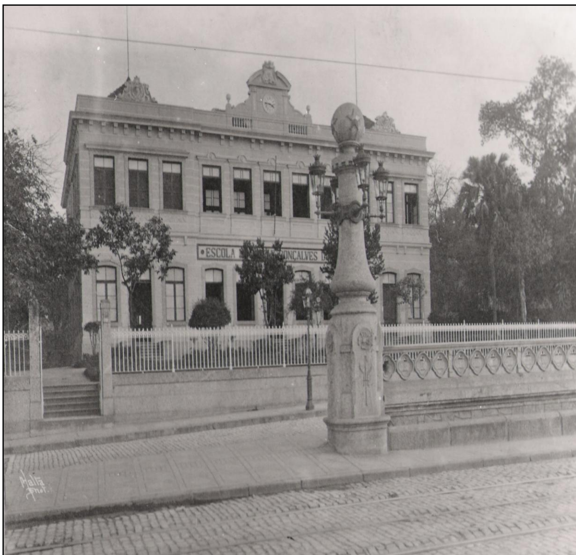
Fotografia 4: Escola da Freguesia de São Christovão. Após a reforma, conforme está mantida na atualidade, Escola Gonçalves Dias. Fotografia de Augusto Malta, sem data. Fonte: AGCRJ – Iconografia: pasta 138; registro 542/10.
