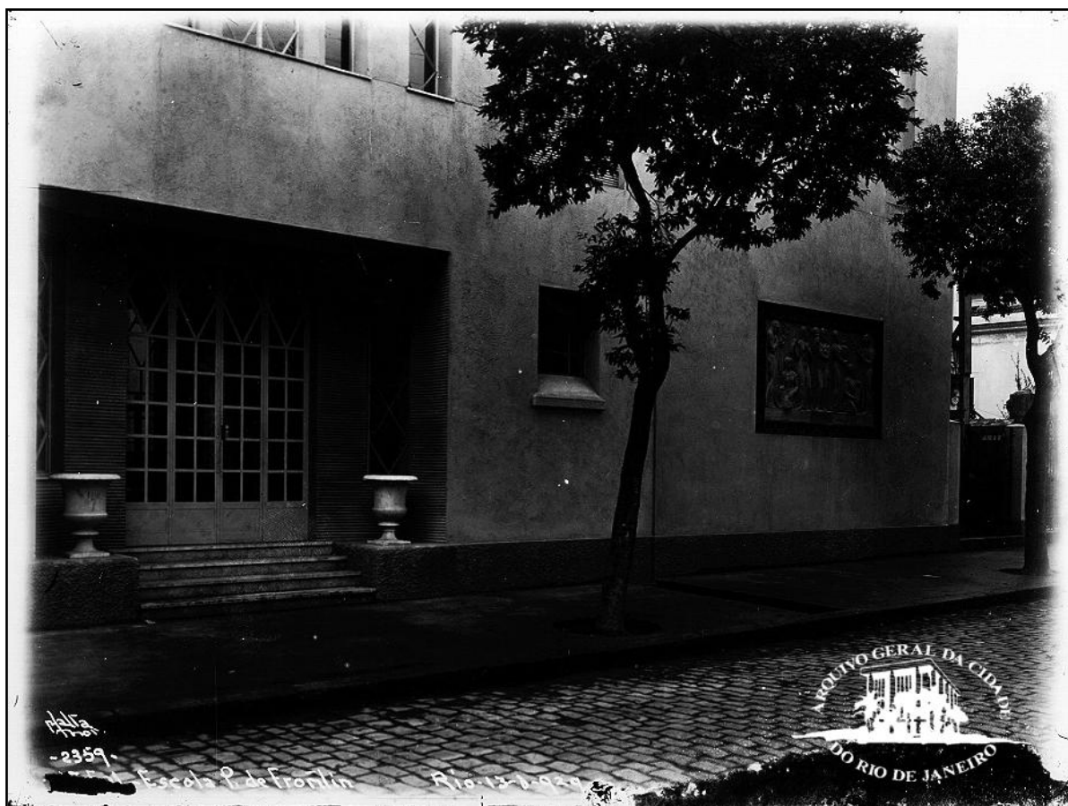
Fotografia 101: Escola Paulo de Frontin. Fonte: Iconografia, AGCRJ. NV0478. Data da fotografia: 13/06/1929. Autor: Augusto Malta. Conteúdo: “Entrada da Escola Paulo de Frontin.” Prédio anexo construído na gestão de Fernando de Azevedo.
