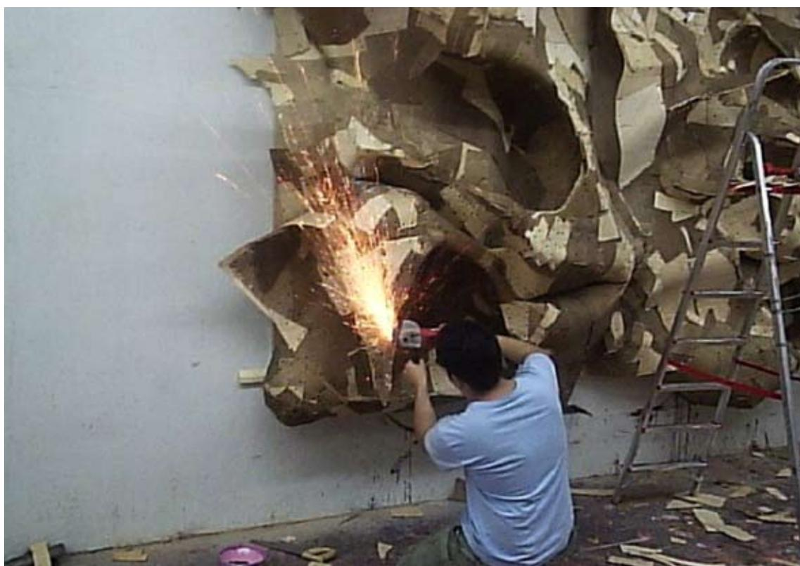
Fig. 56 - Revestimento da estrutura com o compensado flexível.
