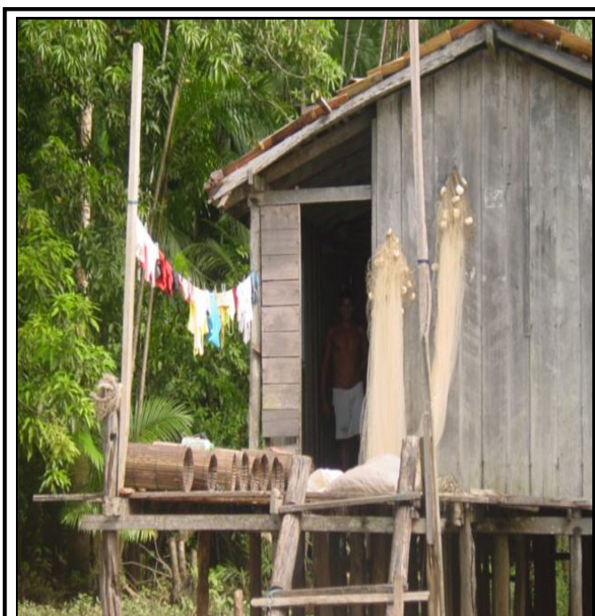
FIGURA 2 – Vista frontal de uma típica casa de pescador no rio Juarimbú, município de Igarapé-Miri. FONTE: FUNDACENTRO – 2006.
