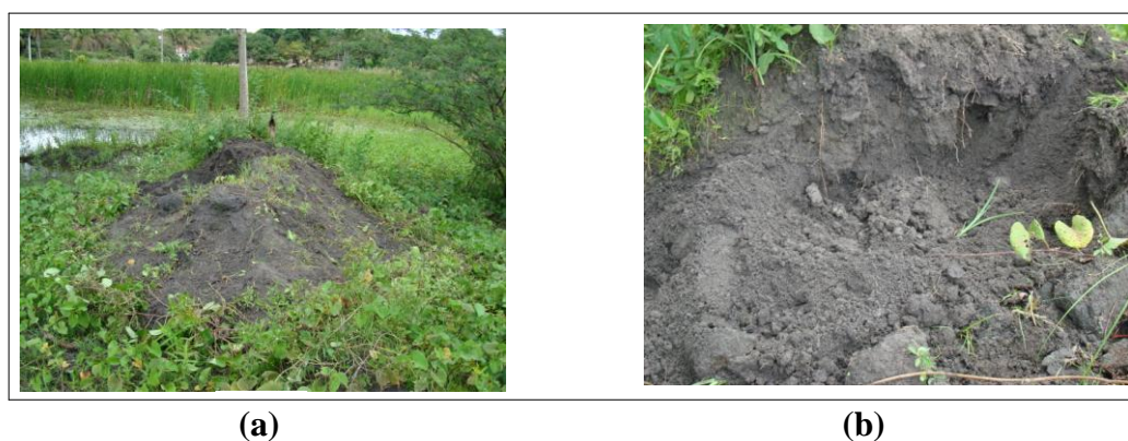
Figura 4.2. (a) Matéria orgânica e vegetação na superfície do solo, (b) Remoção da Matéria orgânica e vegetação
