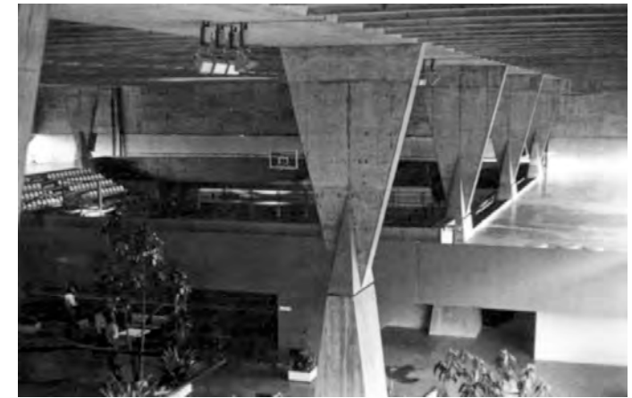
Fig.11 . Sede Social do Jôquei Clube de Goiás. Av. Anhangüera, nº 3653, St. Central. Arquiteto: Paulo Mendes da Rocha Autor: Arquivo Paulo Mendes da Rocha. In: ARTIGAS, 2002. p.125.
