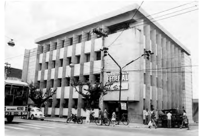
Fig.25 . Agência Caixa Econômica Federal. Av. 24 de Outubro c/ Rua Rio Verde, St. Campinas. Autor: Maria Vanilda Rodrigues de Moraes. In: MORAES, 1984. p.1.
