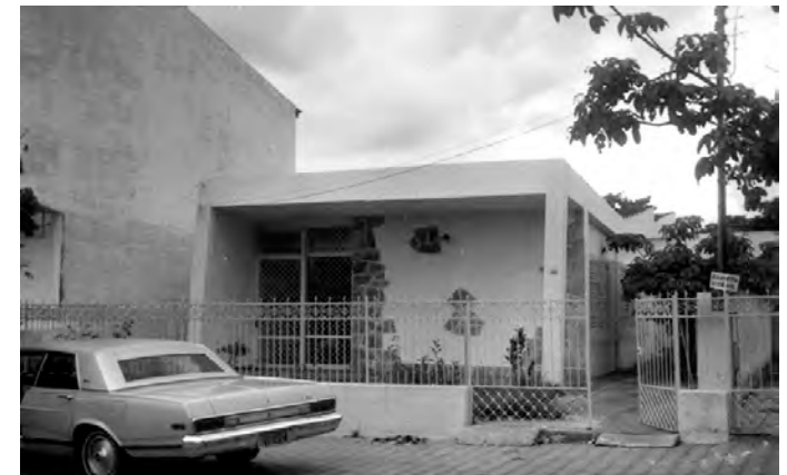
Fig.8 . Residência Rua 84, nº 715, St. Sul. Autor: Não Informado. In: SILVA, 1992 p.26.
