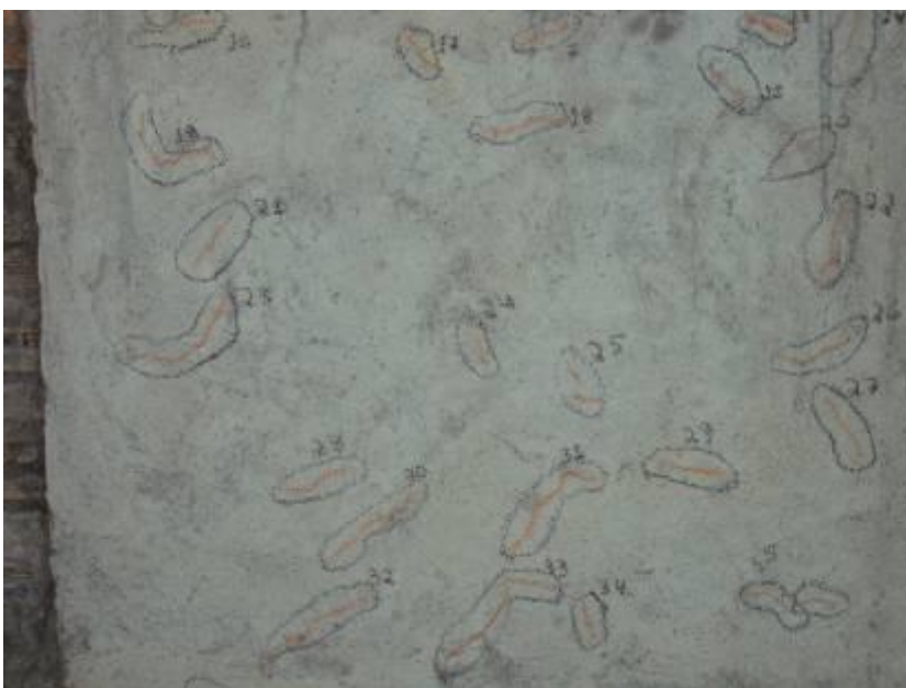
Figura 42 – Revestimento com a argamassa AB1
