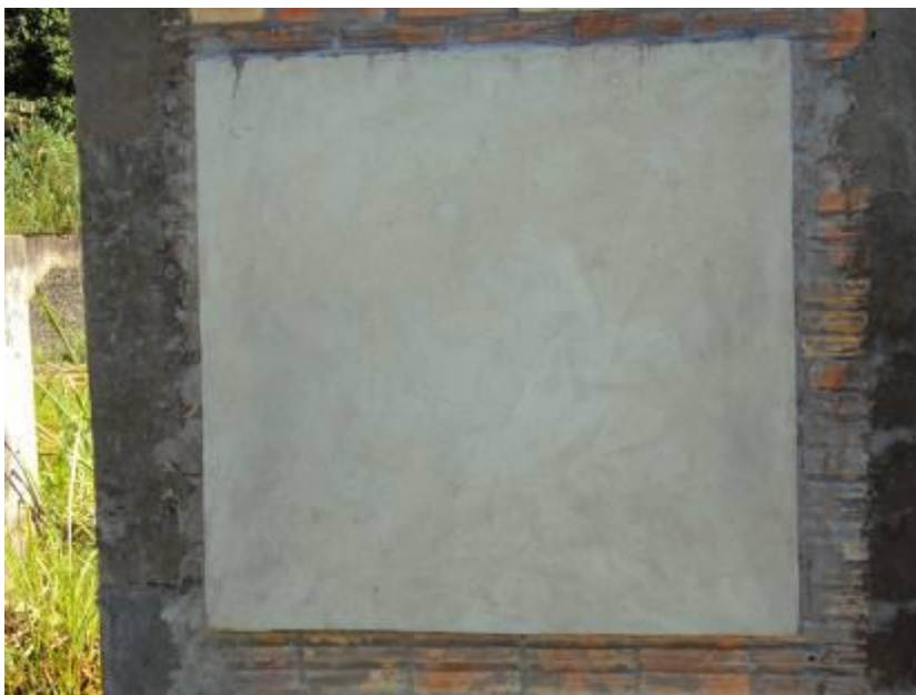
Figura 41 – Revestimento com a argamassa de referência
