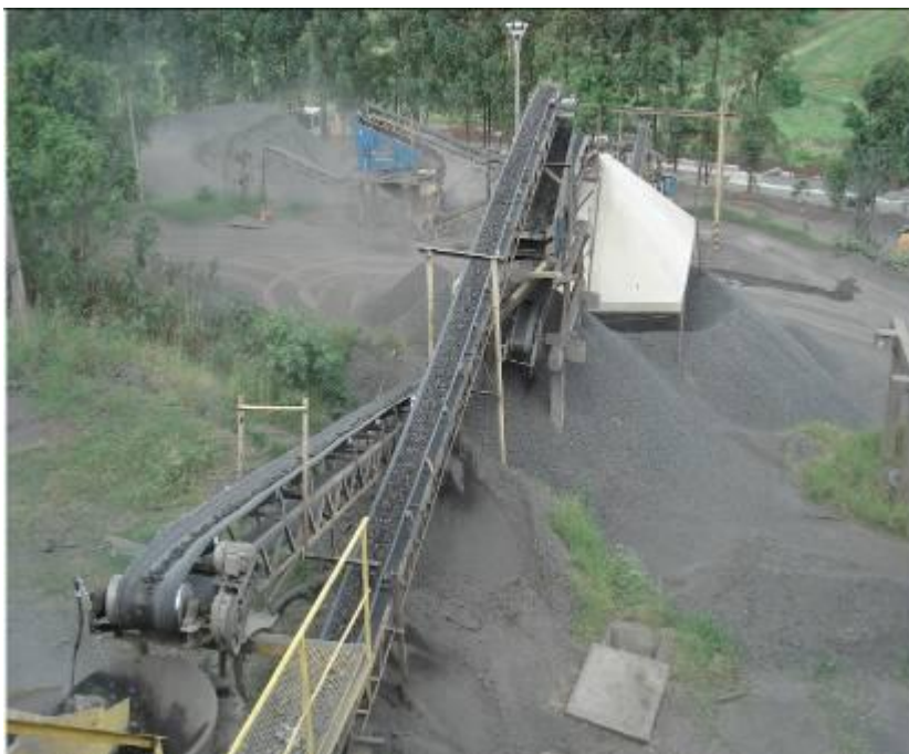
Figura 30 – Usina de britagem em operação – pedreira Guaravera Fonte: Do autor (2009).
