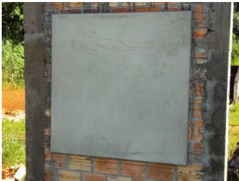
Figura 43 - Revestimento com a argamassa AB2
