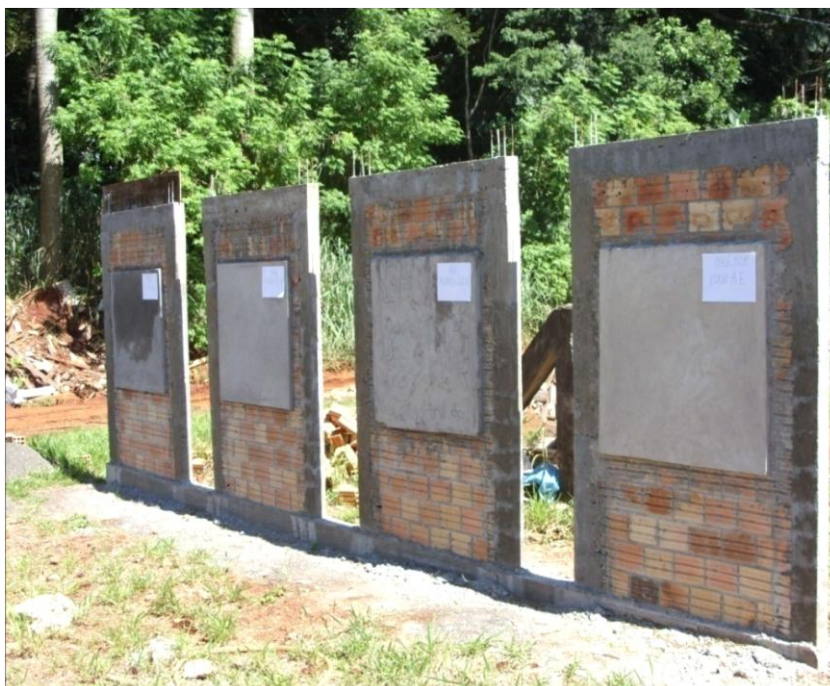
Figura 39 – Face sul das paredes para o ensaio de fissuração
