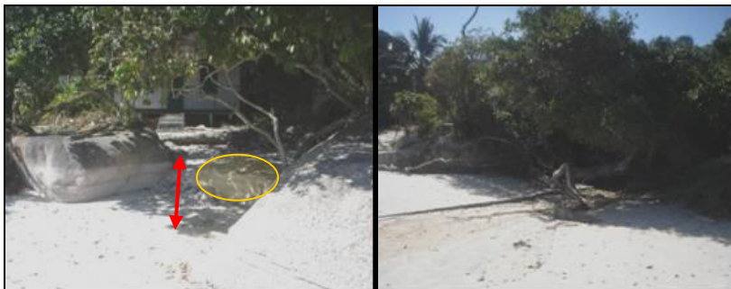
Figura 38. Erosão causada no setor sul da praia da Enseada após passagem de um ciclone extratropical (Foto de Andreoara Deschamps Schmidt, maio de 2008).
