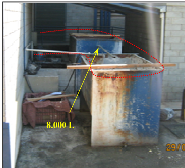
Figura 4.4. Estação de Tratamento de Efluentes Industriais “antes” da implementação da oportunidade de P+L
