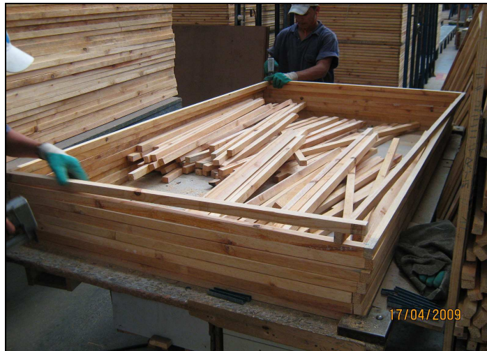
Figura 3.9. Etapa de montagem dos quadros (confeccionados com requadros de madeira de pinus) utilizados na montagem de painéis e portas Fonte: Acervo pessoal, imagem obtida em 17 de abril de 2009
