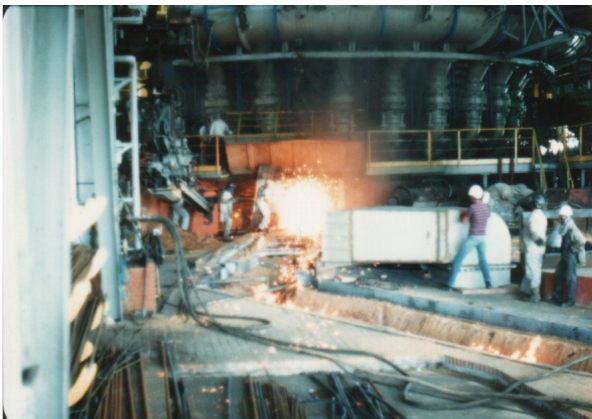
Figura 8 - Fotografia - Atividade com risco de queimaduras e de inalação de gases, em área de corrida, na segunda reforma de Alto-Forno da Siderúrgica Um.
