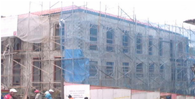
Figura 21: término do telhado do novo edifício. Fonte: Labybe Maria, 2005
