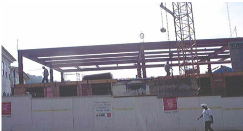
Figura 17: confecção da laje do novo edifício. Fonte: Labybe Maria, 2005
