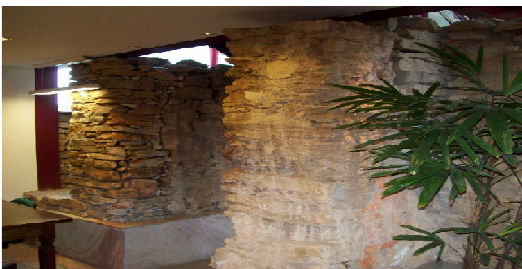
Figura 59: antiga fundação servindo de decoração e sustentação.2009
