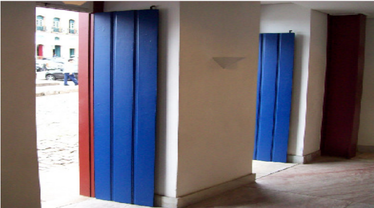
Figura 47: espessura das paredes perimetrais.2009
