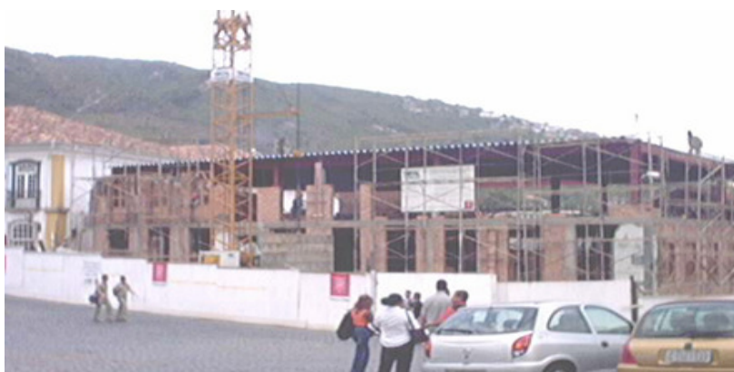
Figura 18: confecção da alvenaria do novo edifício. Fonte: Labybe Maria, 2005
