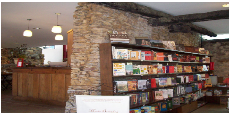
Figura 36: arte da fundação preservada do antigo Hotel Pilão.2009
