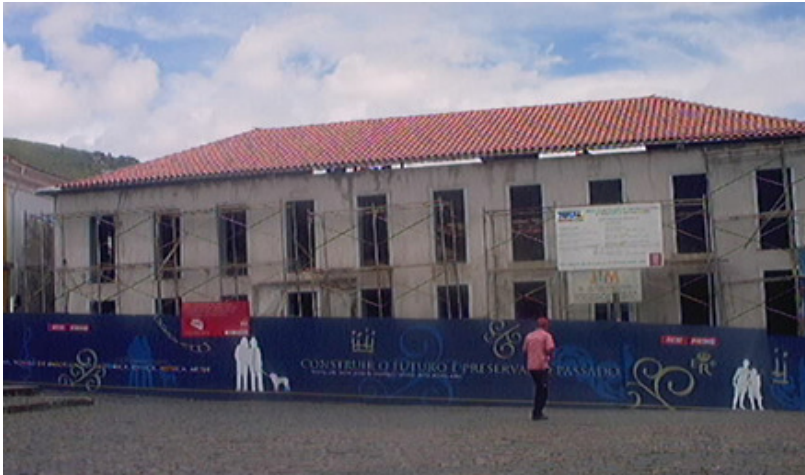
Figura 23: reboco pronto do novo edifício. Fonte: Labybe Maria, 2006
