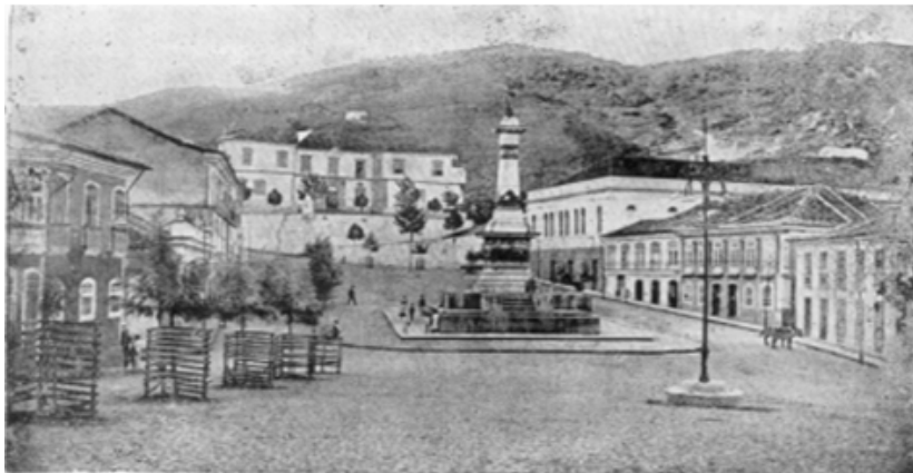
Figura 5: estilo arquitetônico da cidade de Ouro Preto no século XVIII (Fonte IPHAN, 2008).
