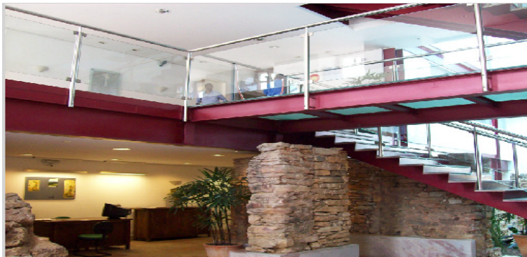
Figura 58: fundação do antigo prédio servindo de colunas.2009
