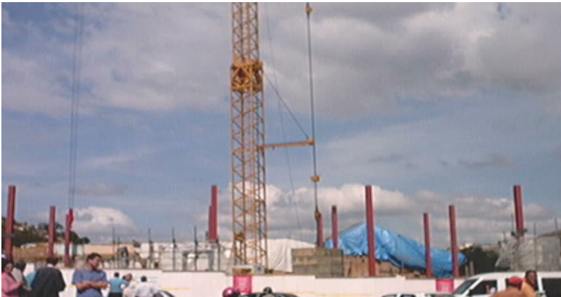
Figura 16: implantação da estrutura metálica do novo edifício. Fonte: Labybe Maria, 2005
