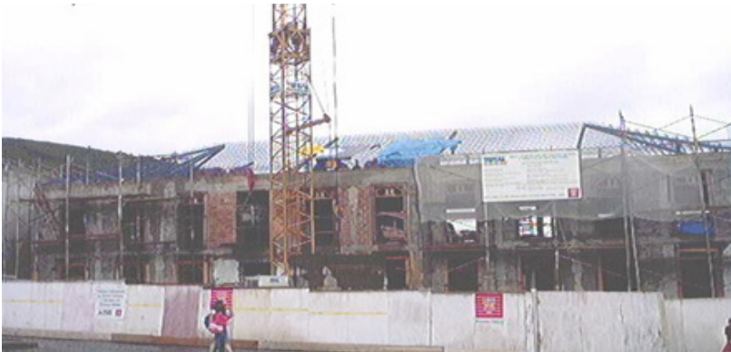
Figura 20: montagem da estrutura da cobertura do novo edifício. Fonte: Labybe Maria, 2005
