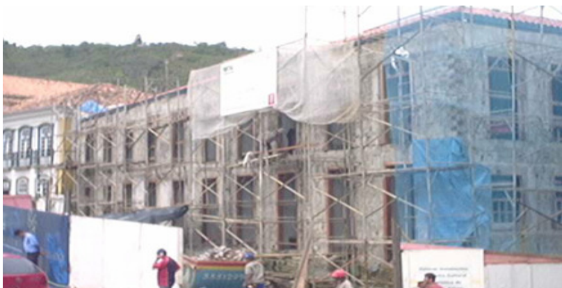
Figura 22: confecção do reboco paulista do novo edifício. Fonte: Labybe Maria, 2005
