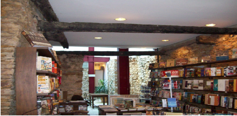
Figura 34: vigas antigas de madeira preserv. e aparentes do Antigo Hotel Pilão.2009
