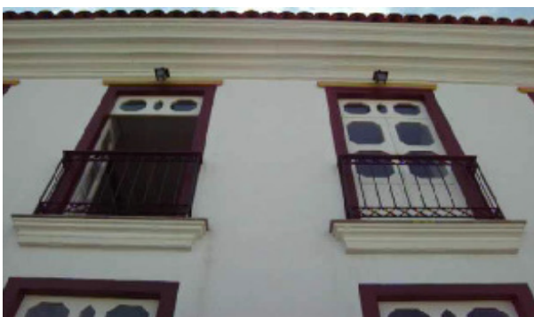
Figura 49: janelas da fachada sul no pav. térreo.2009
