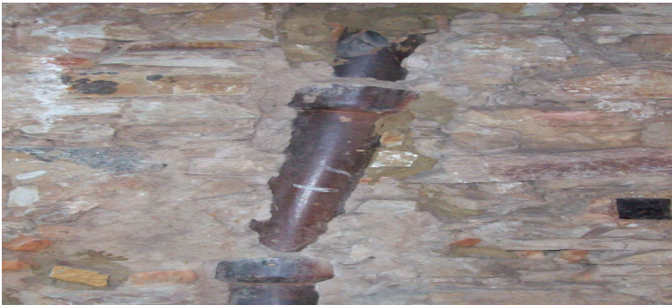
Figura 35: antiga instalação hidro-sanitária do prédio.2009
