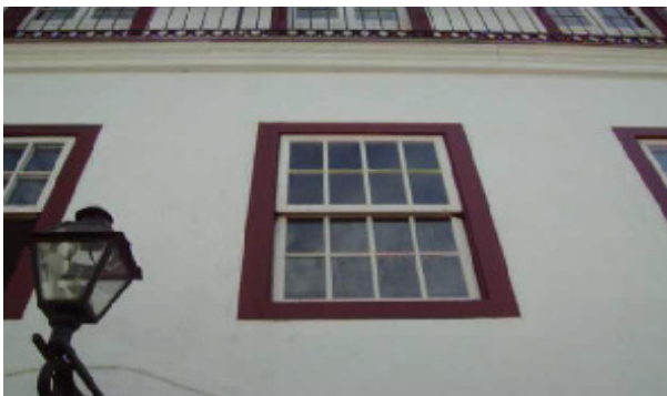
Figura 48: janelas da fachada principal.2009
