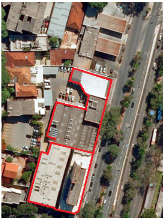
Figura 12. Vista aérea da área de cobertura da concessionária Carbel
