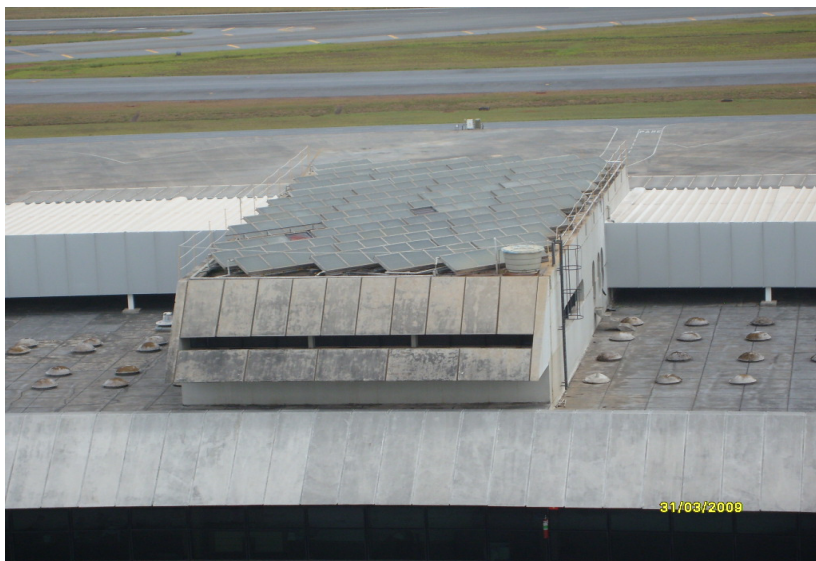
Figura 17 - Vista da cobertura da casa de máquinas e restaurante do Aeroporto Internacional de Confins. (Setor E).
