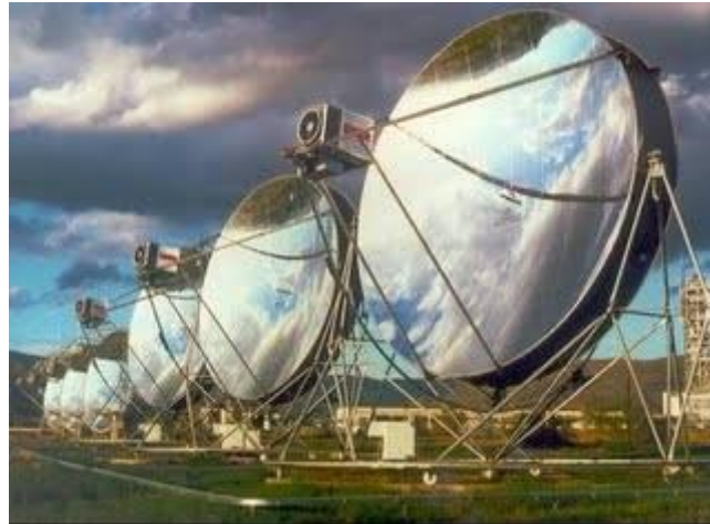
Figura 3.4 – Coletor solar modelo de sistema de parabólica com motor stirling. Campo Solar Eurodish na Alemanha. FILHO (2008, p.17).
