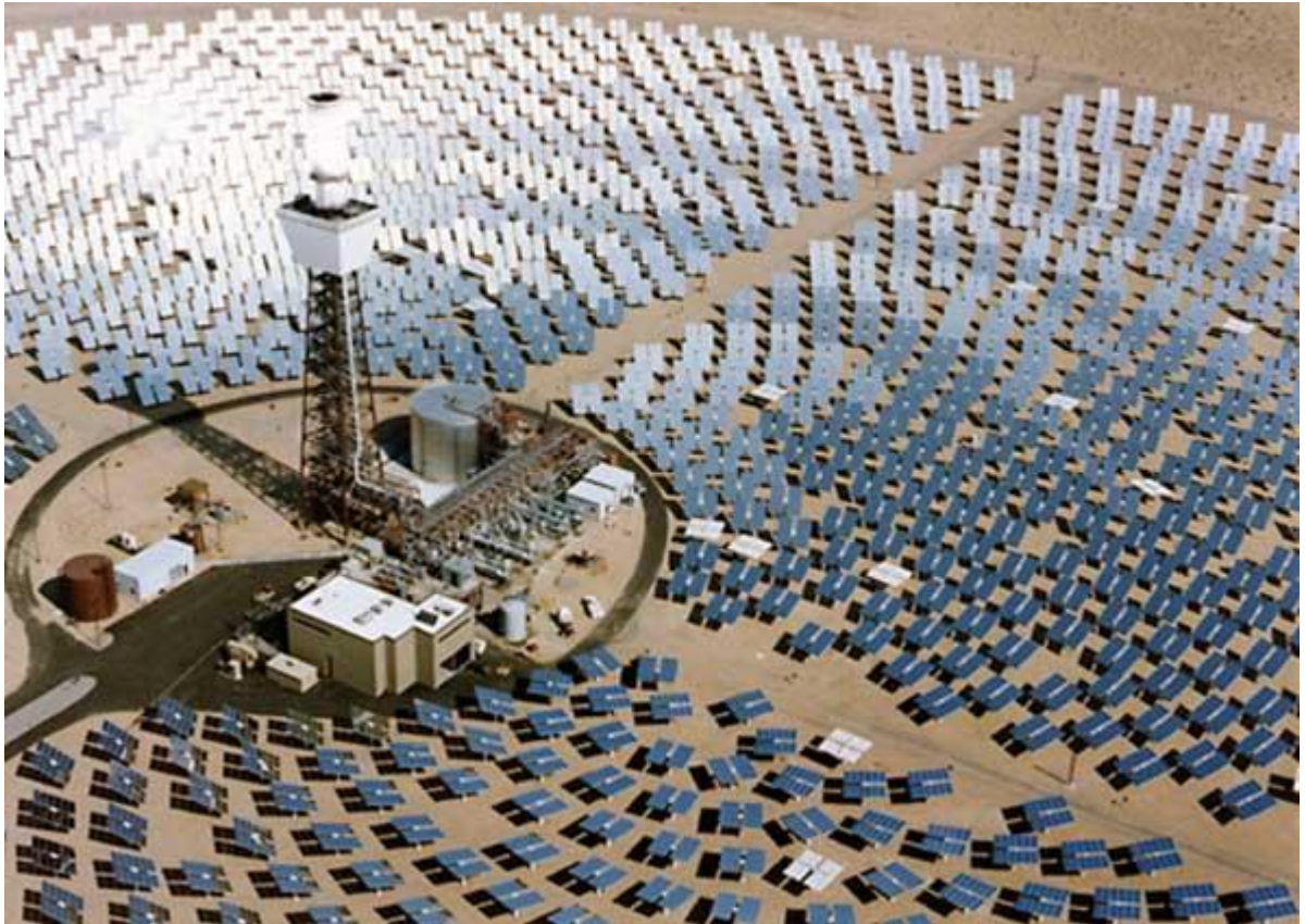
Figura 3.5 – Imagem de uma torre de potência. Foto: AFP/Solar Systems. www.g1.globo.com.br
