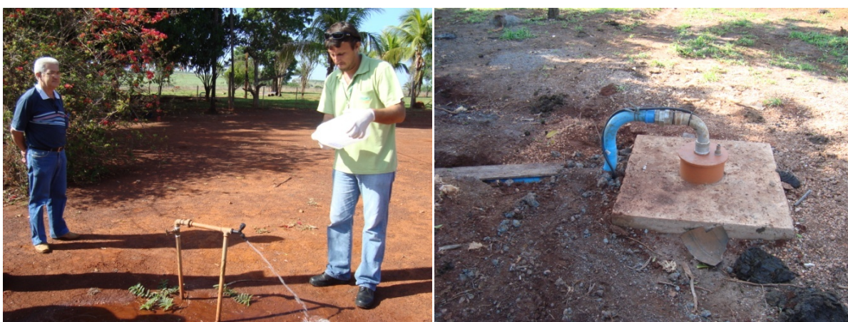
Figura 11 Poço PT6 do DAE Juscimeira.
