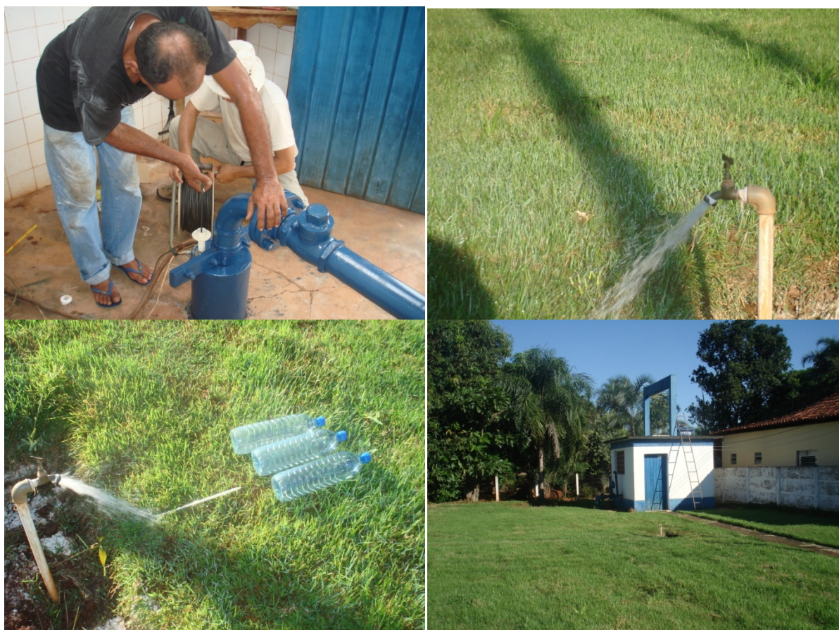
Figura 21 Poço PT1 DAE Dom Aquino, cidade de Dom Aquino.
