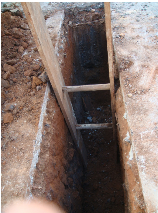
FIGURA 5.23 – Abertura e escoramento da vala - Vala Experimental 2.
