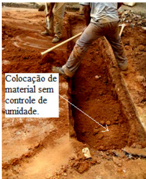
FIGURA 4.2 – Espalhamento manual de material na vala.
