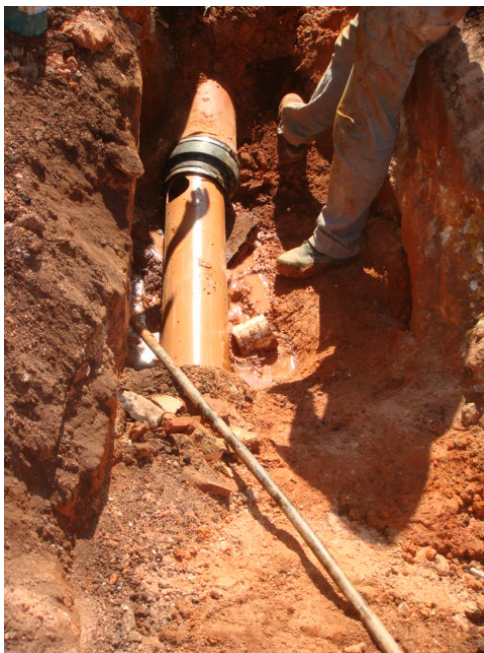
FIGURA 4.83 – Reparo de rede de esgoto -Vala 6.
