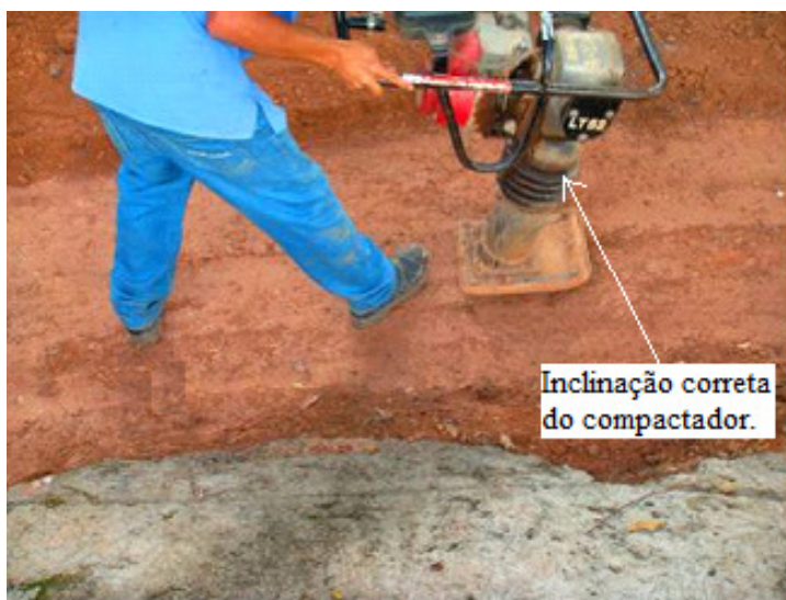
FIGURA 5.5 – Segunda passada para compactação da quarta camada - Vala Exp. 1.
