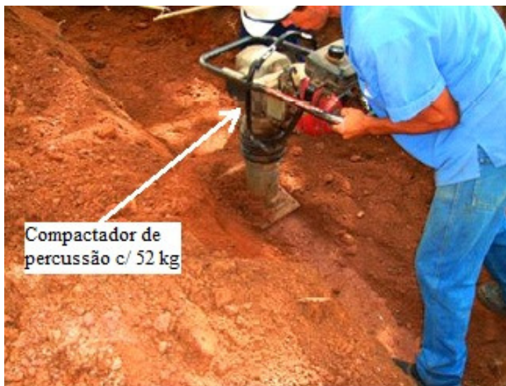
FIGURA 5.4 – Início da compactação da primeira camada (primeira passada) - Vala Exp. 1.
