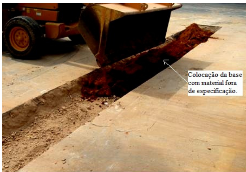
FIGURA 4.3 – Colocação de material de base.
