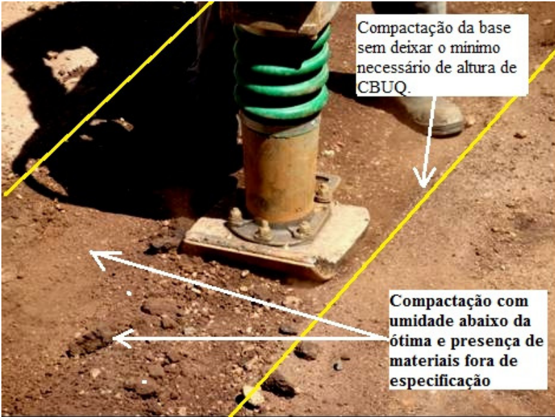
FIGURA 4.5 – Compactação de camada de base.
