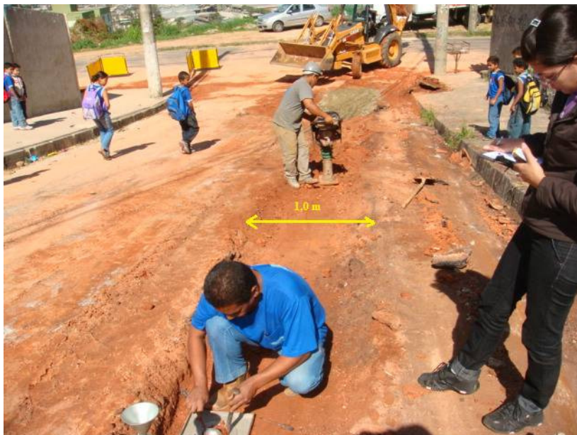
FIGURA 4.84 – Compactação da última camada e ensaio do Frasco de Areia - Vala 7.
