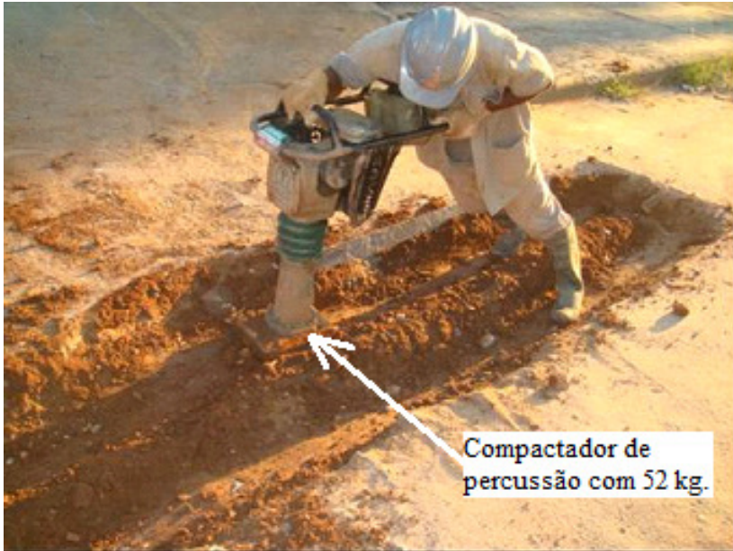
FIGURA 4.56 – Compactação da última camada (subleito) com o mesmo material retirado da vala – Vala 4.
