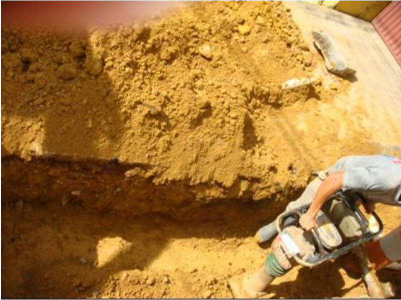
FIGURA 4.44 – Primeira passada na compactação da camada – Vala 3.
