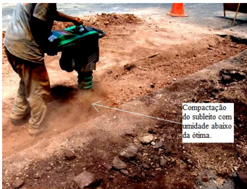
FIGURA 4.4 – Compactação da camada de subleito.
