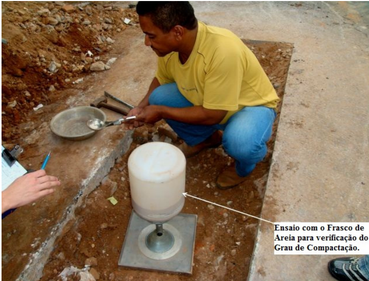
FIGURA 5.27 – Ensaio com o frasco de areia na última camada - Vala Exp. 2.
