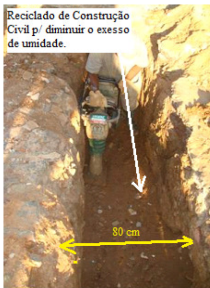
FIGURA 4.55 – Compactação da última camada com reciclado de construção civil – Vala 4.
