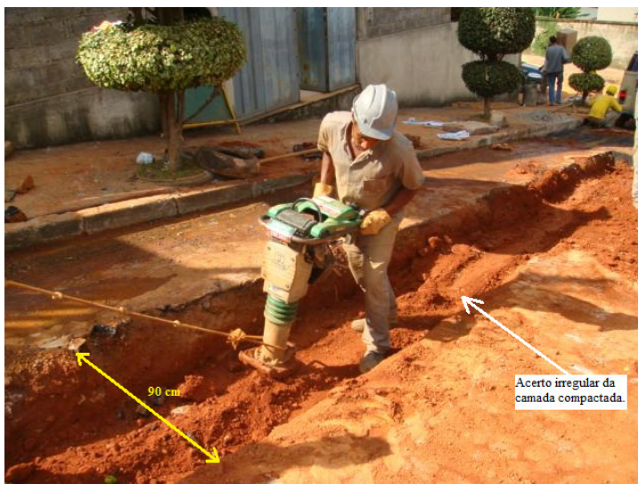
FIGURA 4.92 – Compactação da penúltima camada do subleito sem acerto da camada - Vala 8.
