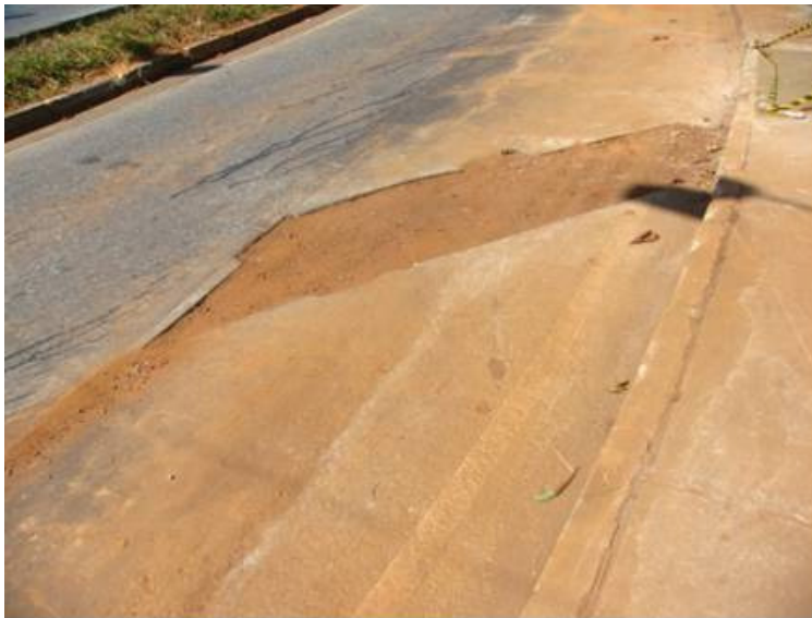
FIGURA 4.75 – Acabamento final com base com canga de ninério de ferro -Vala 6.
