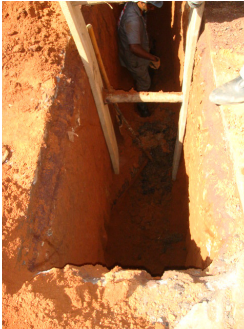
FIGURA 4.64 – Escoramento da vala para reparo da rede de esgoto - Vala 5.
