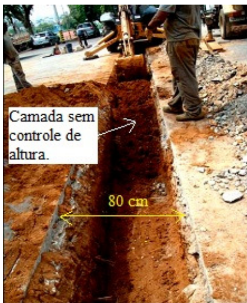
FIGURA 4.1 – Espalhamento mecanizado de material na vala.
