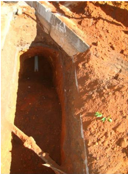
FIGURA 4.74 – Reparo de rede de água, fundo de vala -Vala 6.
