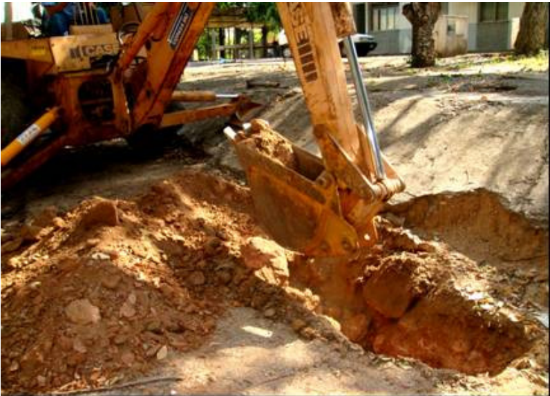
FIGURA 5.1 – Escavação para coleta de material - Vala Experimental 1.
