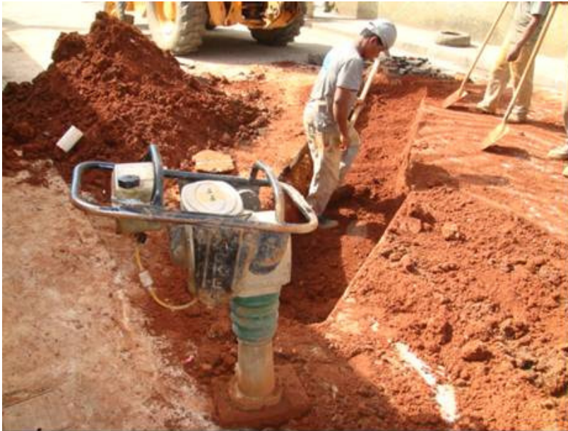
FIGURA 4.35 – Espalhamento do material para compactação da última camada (subleito) – Vala 2.
