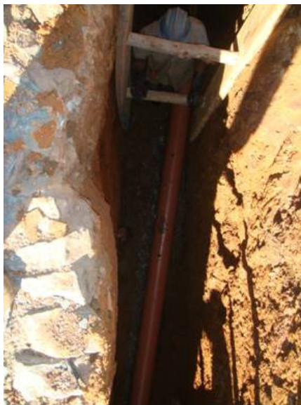
FIGURA 4.54 – Reparo da rede de esgoto após colocação de reciclado de construção civil – Vala 4.
