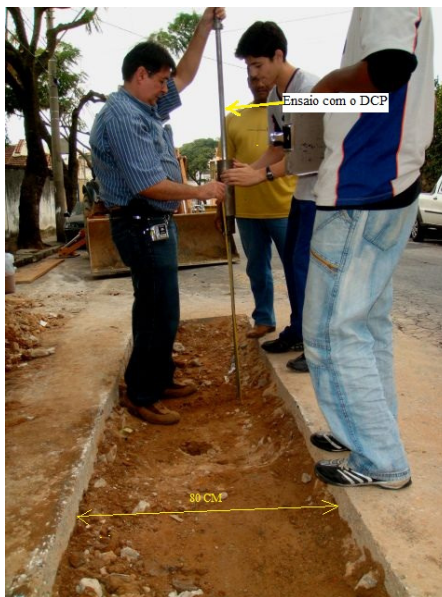
FIGURA 5.28 – Segundo ensaio com o DCP, com distância de 1m do primeiro furo e afastamento de 15 cm do bordo - Vala Exp. 2.
