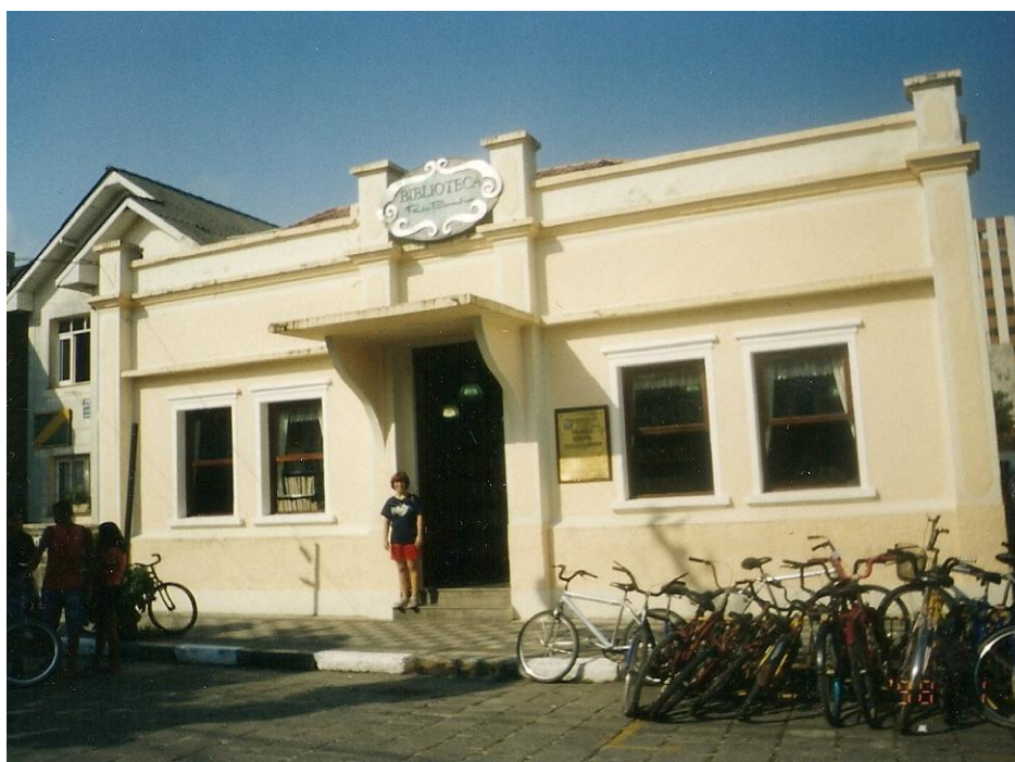
Figura 3 - Fachada da Biblioteca Pública de Itanhaém, 2007
