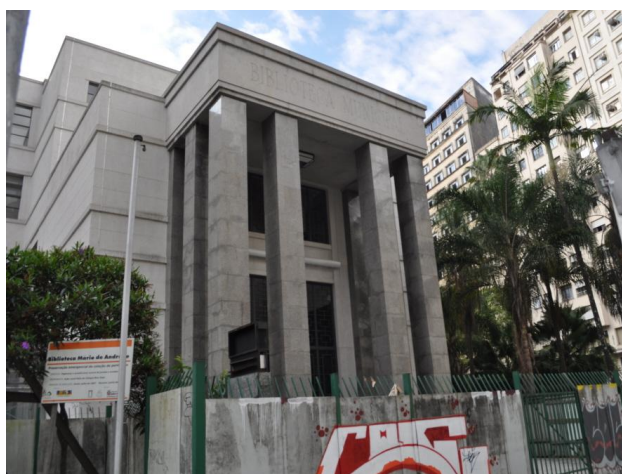
Figura 2 - Fachada da Biblioteca Mario de Andrade em reforma desde 2007- São Paulo, 2010
