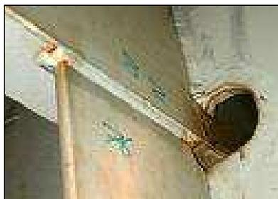
Figura 9 - Corrosão causada pela tensão em estrutura metálica (Amtec, 2010)
