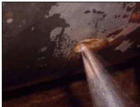
Figura 5 - Corrosão por *pite* em chapa metálica (ABRACO, 2010)
