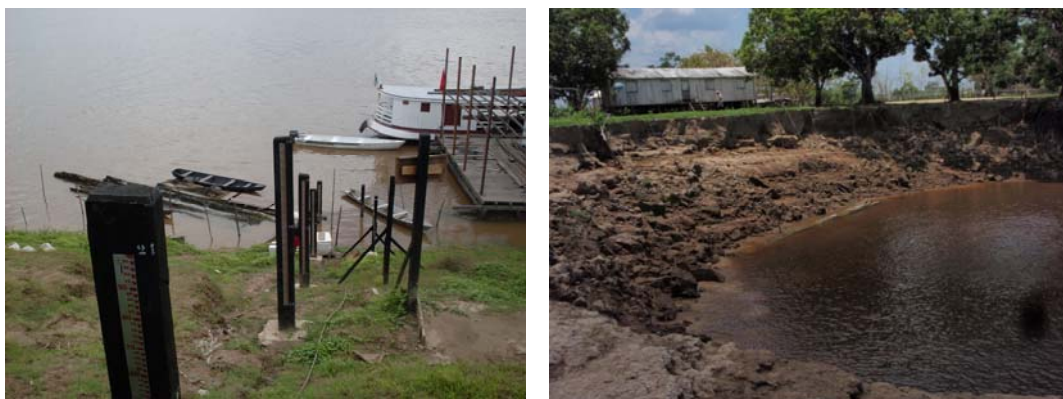
Figura 1.1 - Estação fluviométrica Porto União antes (foto esquerda) e depois (foto direita) de um evento de desbarrancamento.
