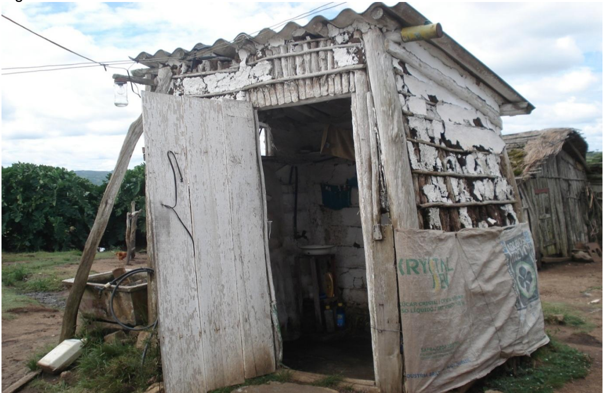
Figura 46: Banheiro construído no exterior da casa
