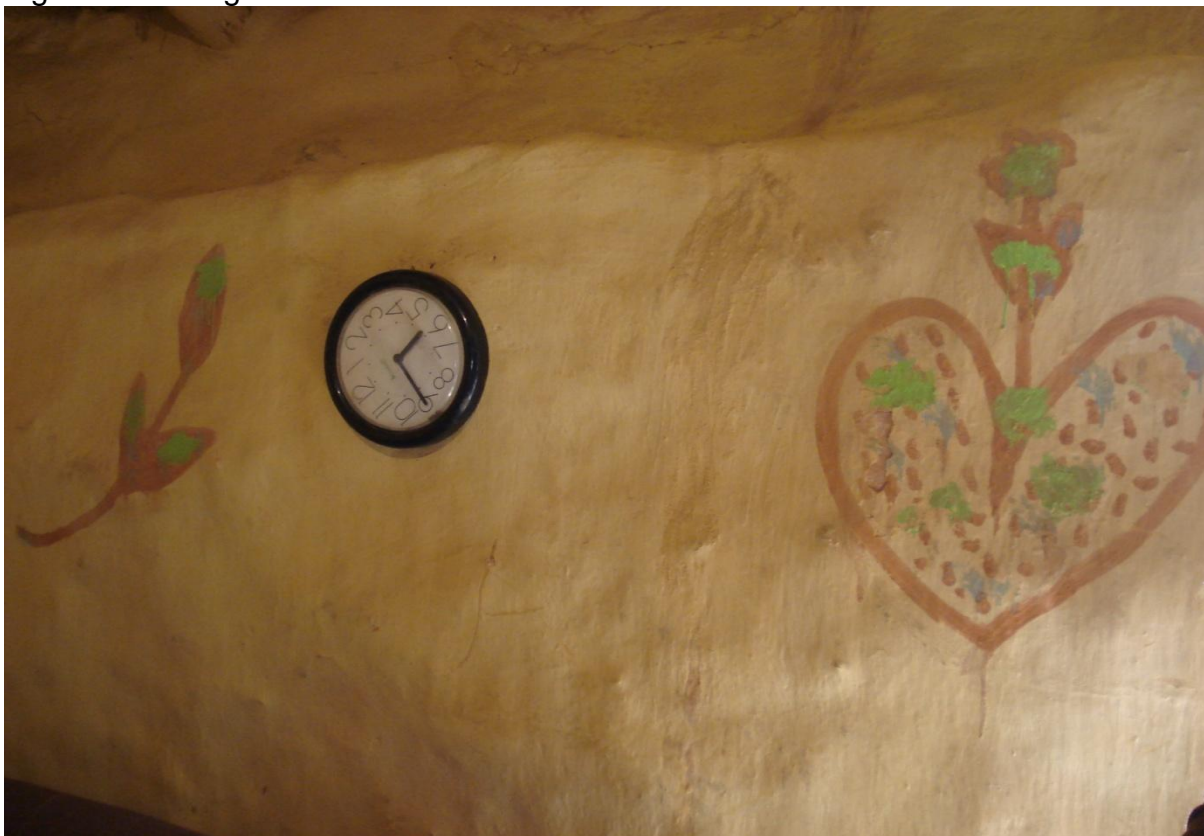
Figura 62: Relógio instalado na sala de estar
