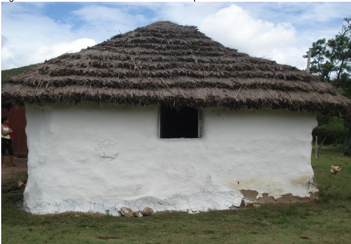
Figura 39: Casa de barro com reboco de cal e palha santa-fé
