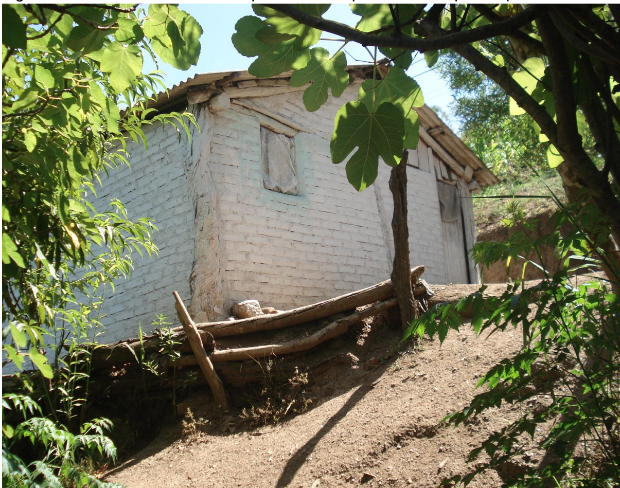
Figura 07: Residência sustentada por madeiras para não dissipar-se pelo cerro
