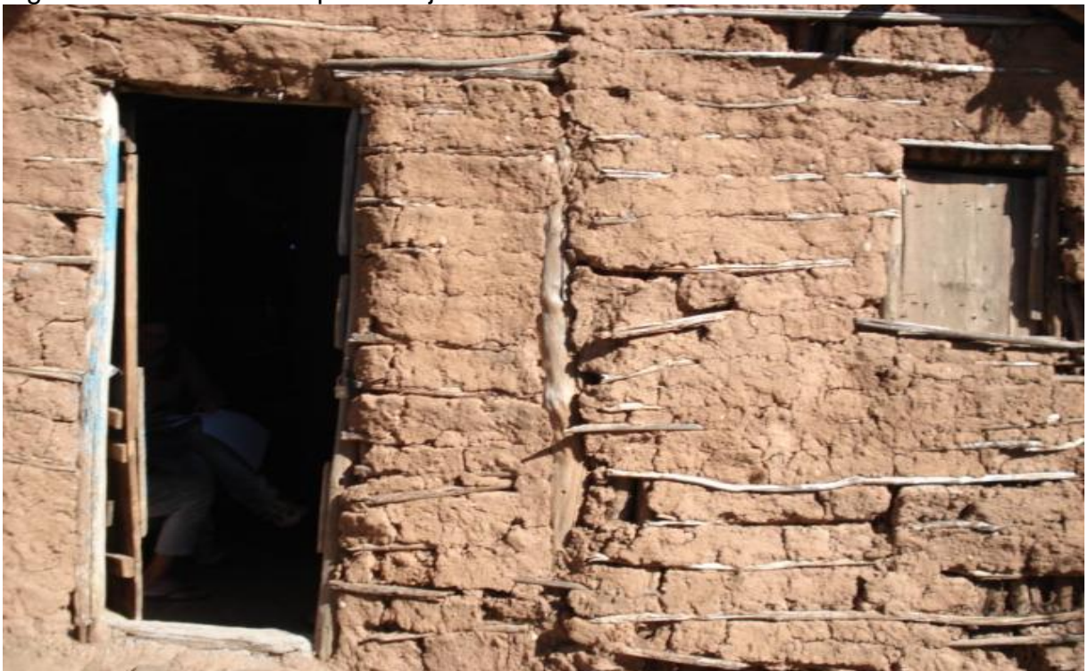
Figura 41: Estrutura das portas e janelas
