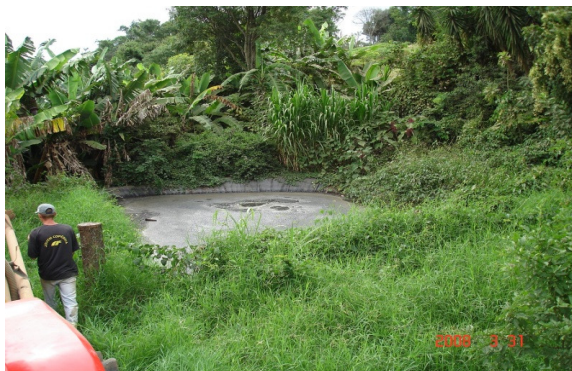
Figura 15 – Esterqueira em mal estado de conservação e funcionamento.
