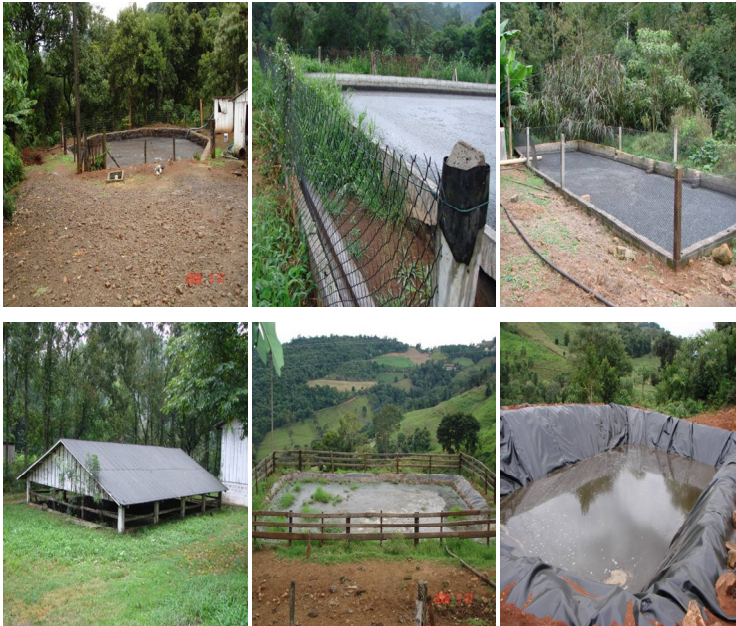
Figura 13 – Esterqueiras em bom estado de conservação e funcionamento
