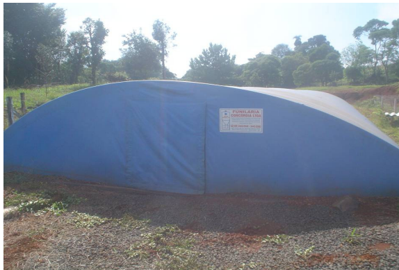
Figura 23 – Cisternas de armazenagem de água da chuva aproveitada de calhas de granjas de suínos – Concórdia - SC
