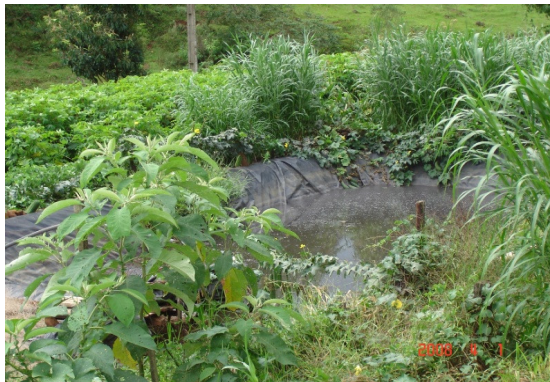
Figura 14 – Esterqueira em mal estado de conservação e funcionamento.
