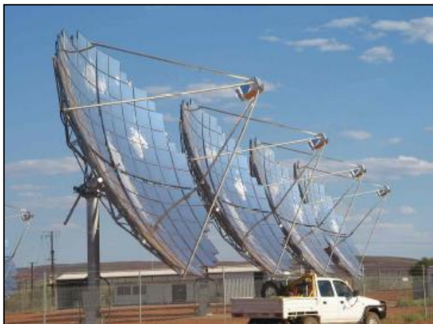
Figura 2.27 – Planta fotovoltaica de 220 \text{ kW}_N , instalada em Hermannsburg, Austrália, com SFVC de óptica reflexiva da empresa Solar Systems. Fonte: (VERLINDEN et al. , 2008)
