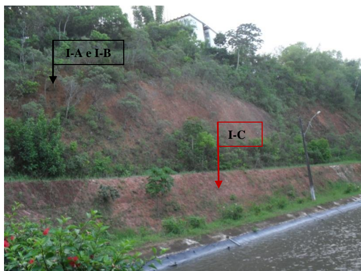
Figura 10 – Talude de corte e a indicação dos horizontes observáveis
