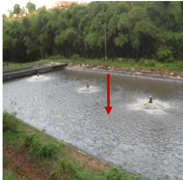
Figura 9(a) – Primeira lagoa, tratamento preliminar do efluente bruto.
