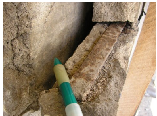
Figura 49: Detalhe da barra chata de reforço
