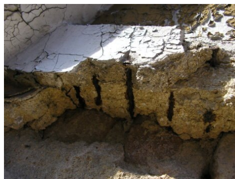
Figura 45: A perda de material de um friso de adorno junto ao óculo da janela WN23 deixa à mostra cravos oxidados, empregados na armação de frisos
