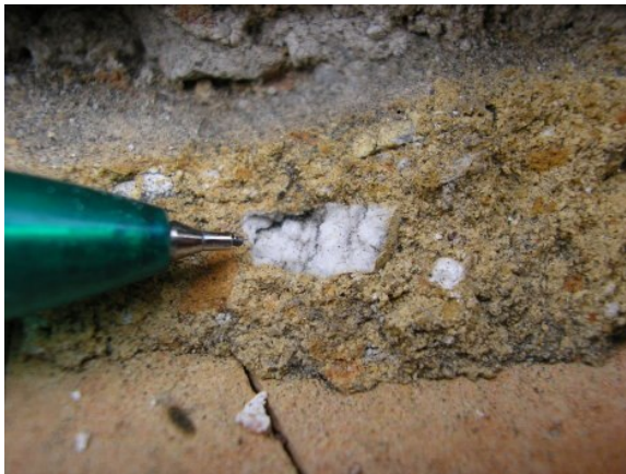
Figura 91: Agregado calcário de origem mineral presente na argamassa de emboço alaranjada (N13)
