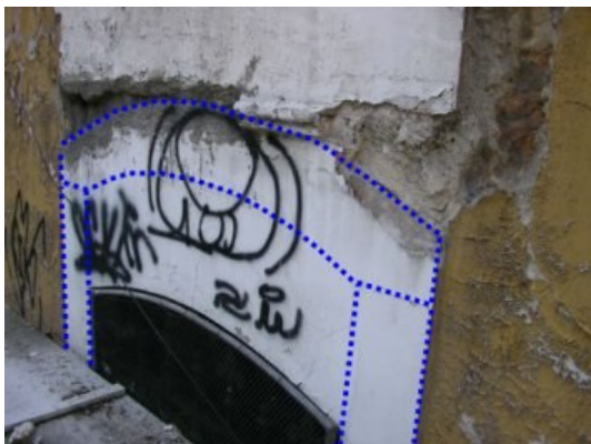
Figura 56: WS12 - Arco da cantaria (indicado pelo pontilhado) 28cm mais alto do que a abertura da janela
