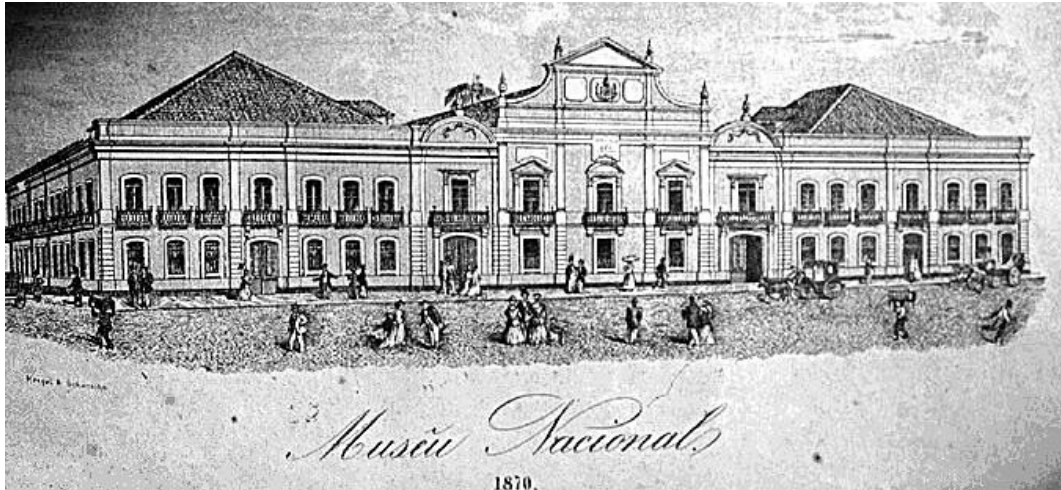
Figura 15: Ilustração datada de 1870, quando o edifício abrigava o Museu Nacional Fonte: Autor desconhecido
