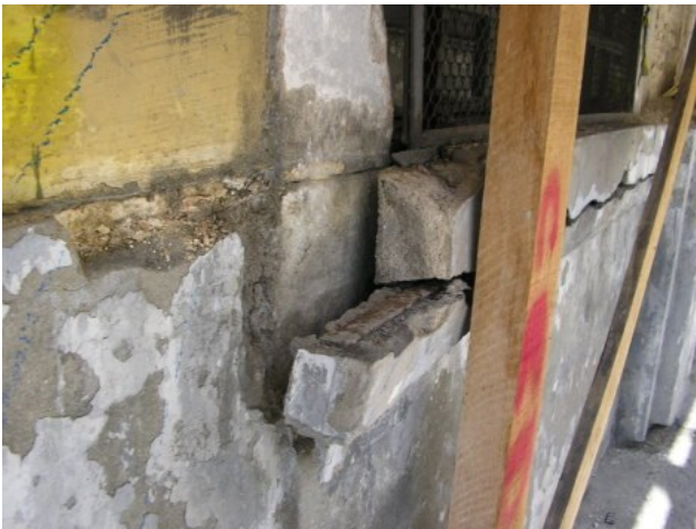
Figura 48: Parapeitos no térreo, em argamassa reforçada com barra chata de ferro. Atrás, a cantaria do séc. XIX
