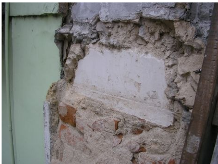
Figura 59: N21- Argamassa de acabamento encontrada sob a argamassa de acabamento atual
