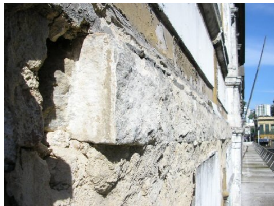
Figura 55: WN25 – Detalhe da laje de pedra do balcão, com marcas de corte bruto
