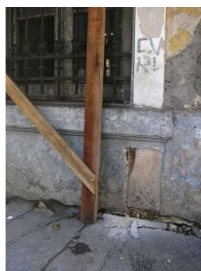
Figura 51: WS17 - Pedra de cantaria indo até o chão, resquício de antiga porta
