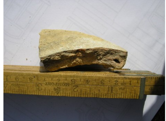
Figura 41: Detalhe de caco de telha colonial empregado para preencher volume na argamassa
