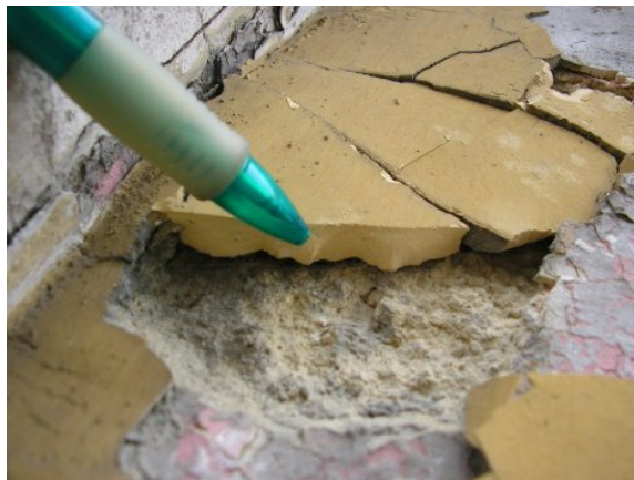
Figura 96: Argamassa pigmentada anormalmente espessa (N21)
