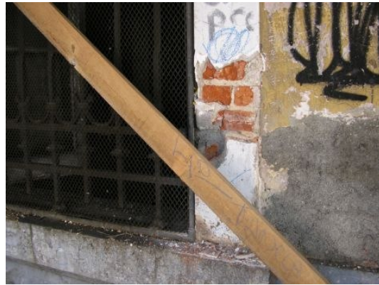
Figura 53: WS14 - Ausência de cantaria, distinguindo do período das demais aberturas
