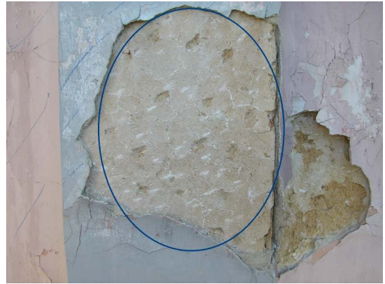
Figura 27: Detalhe de argamassa de emboço exposta, com marcas de apicoado, junto à abertura FC-S-31
