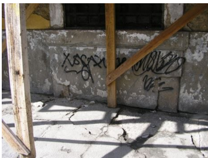
Figura 50: N12 - Pedra de cantaria indo até o chão, resquício de antiga porta
