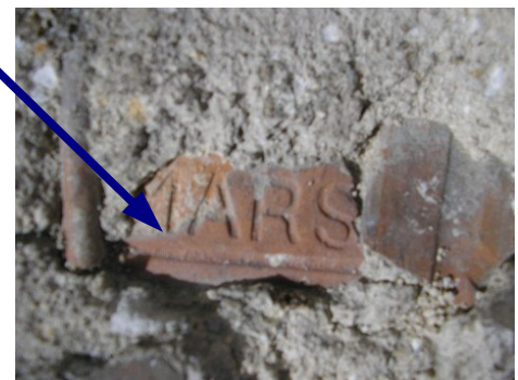
Figura 43: Detalhe de caco de telha marselhesa, junto à WN23
